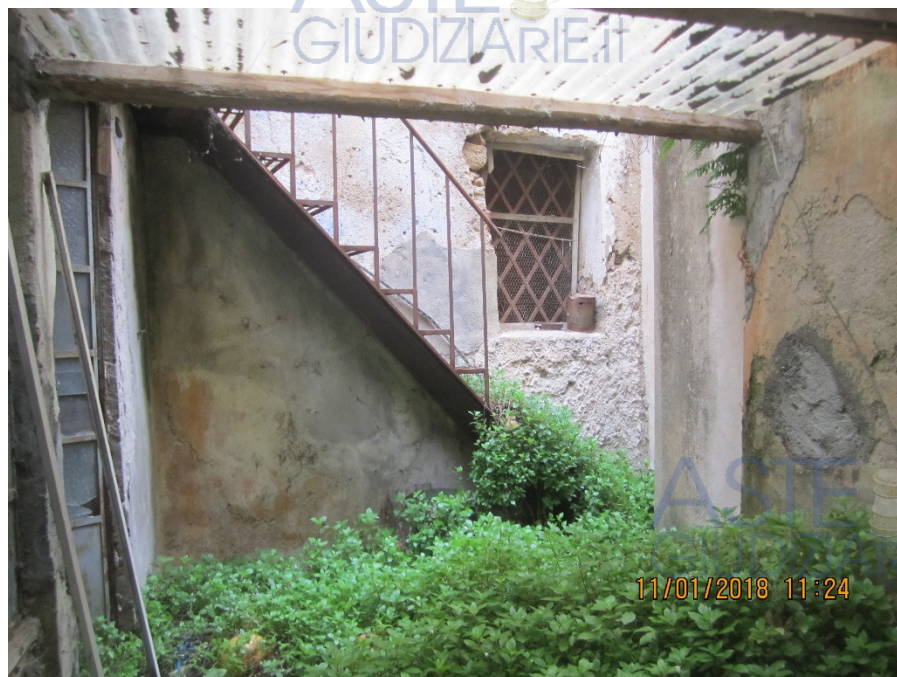
Foto 4: corte di pertinenza. Vista scala in metallo
