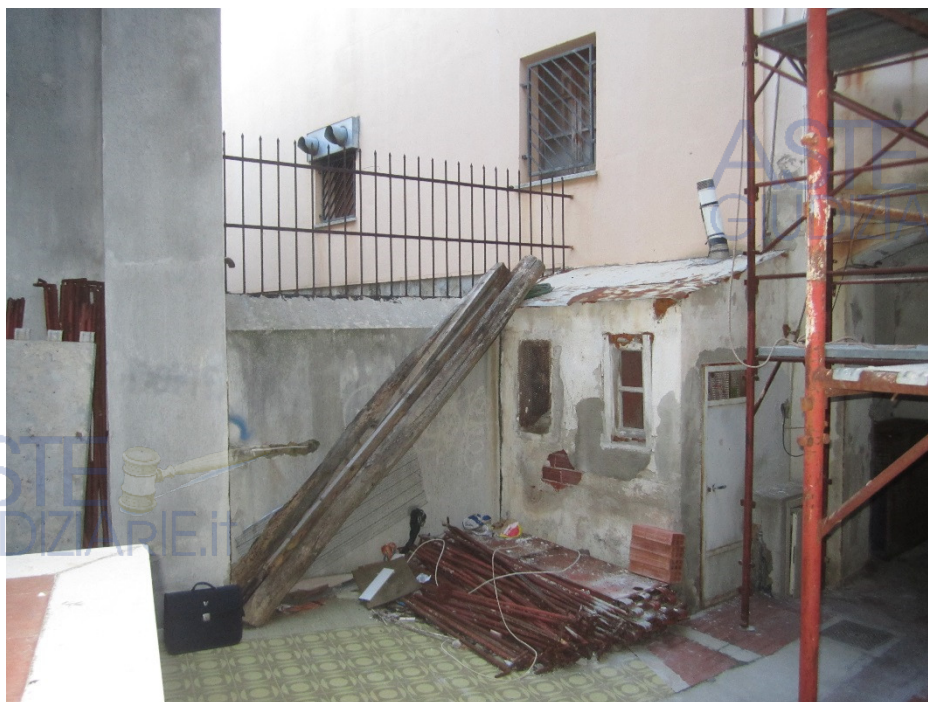
Foto 1: vista muro di confine (lato altra proprietà)
