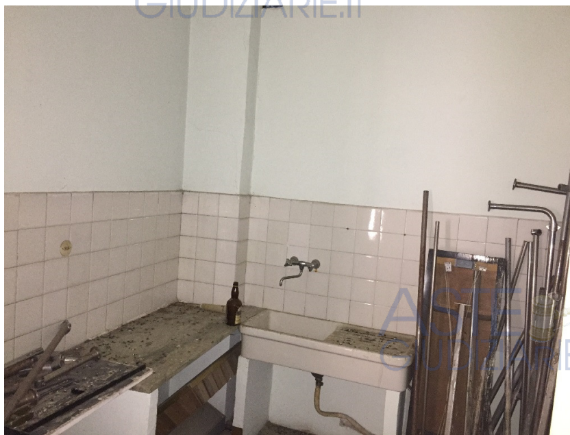
Foto 2: LOTTO A interno P.T/1°
