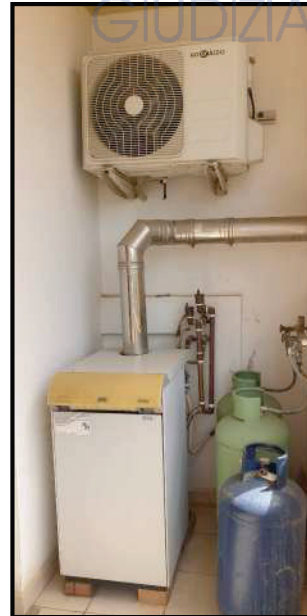
IL BALCONE COPERTO AL PIANO PRIMO
