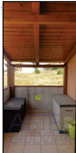
IL BALCONE COPERTO AL PIANO SECONDO
