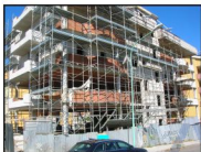
Foto 3 – Modulo in fase di realizzazione
