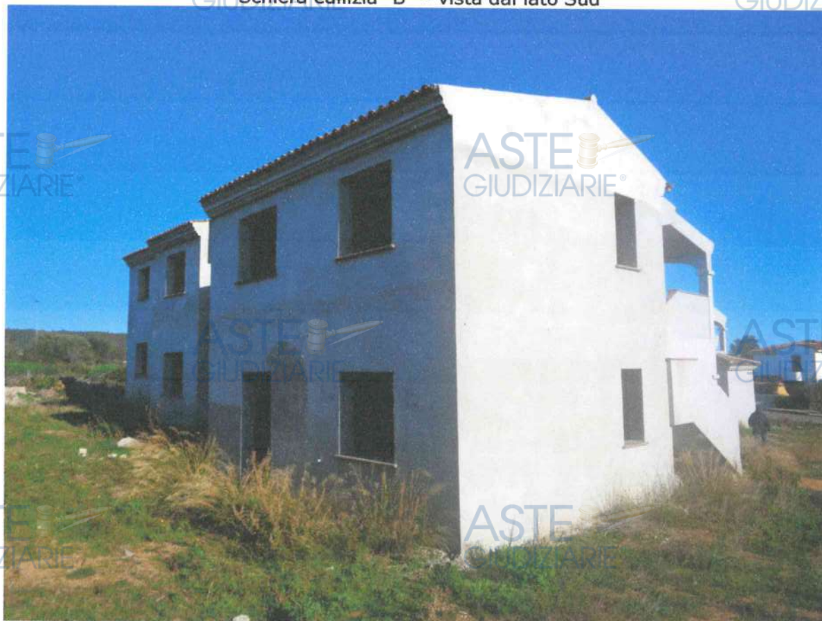
Schiara edilizia "B" – vista dal lato Sud-Ovest
