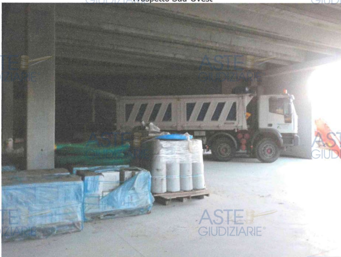
Interno al piano Seminterrato
