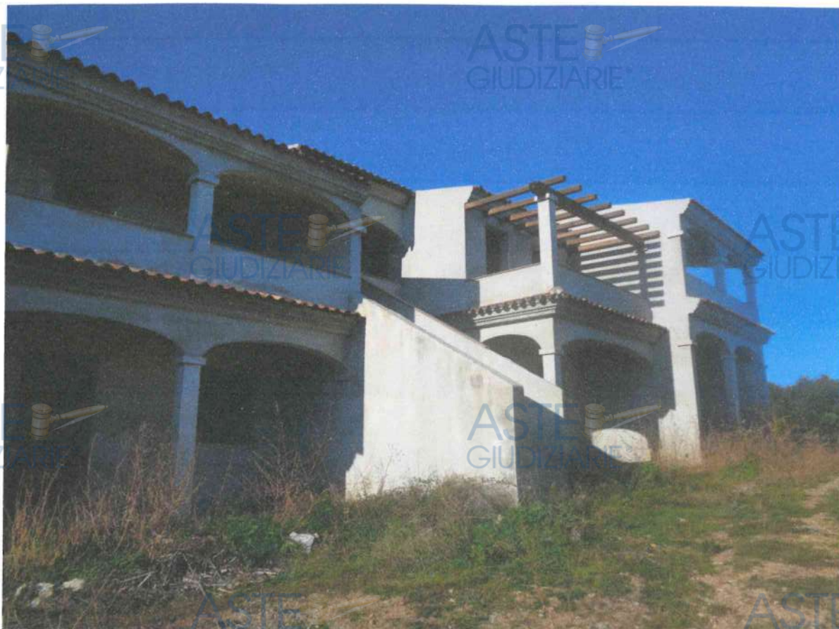
Schiara edilizia "B" – vista dal lato Sud
