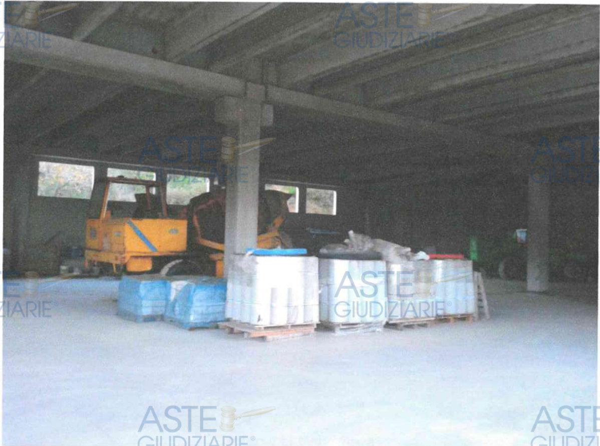
Interni al piano Seminterrato
