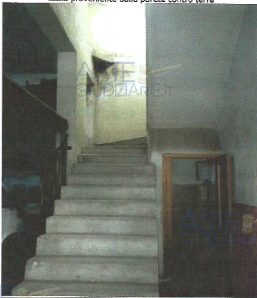
Interni al Piano Seminterrato - foto sotto evidenti tracce di infiltrazione d'acqua nella scala proveniente dalla parete contro terra
