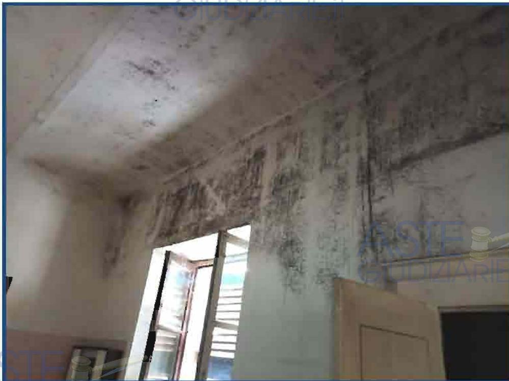
foto 37 - P.1. - Manica Sud-Ovest loc. disimpegno - infiltrazioni copertura
