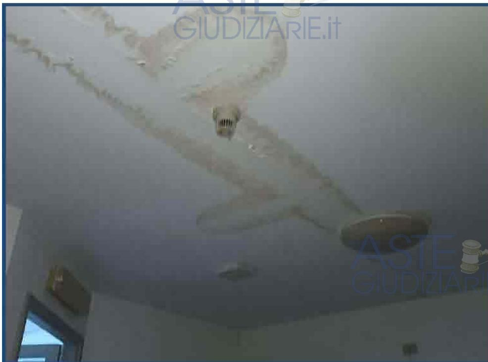
foto 27 - P.T. - Manica Nord-Ovest - bagno assistito - infiltrazioni solaio da copertura piana
