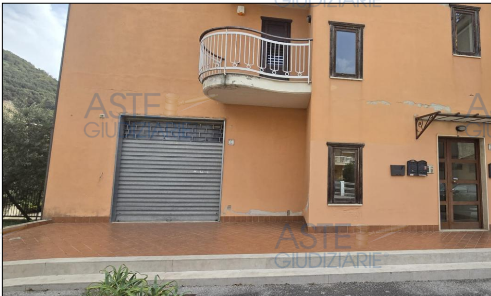
Accesso dalla corte condominiale comune
