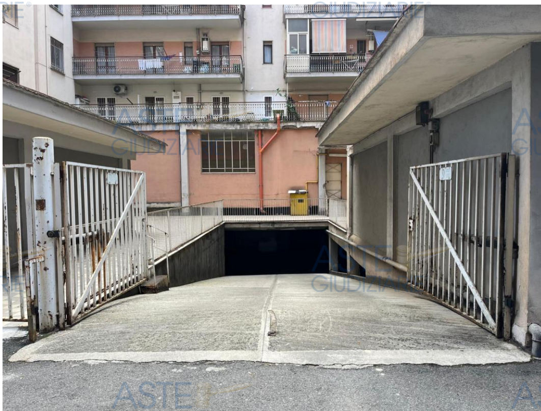
Img 1 - Rampa ingresso garage
