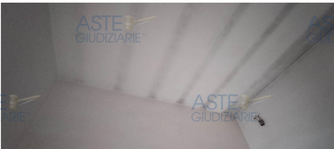
Particolare intradosso solaio
