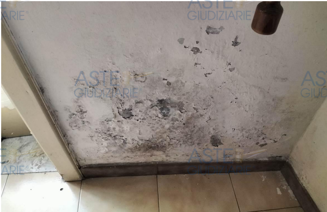
Particolare muratura – camera 1
