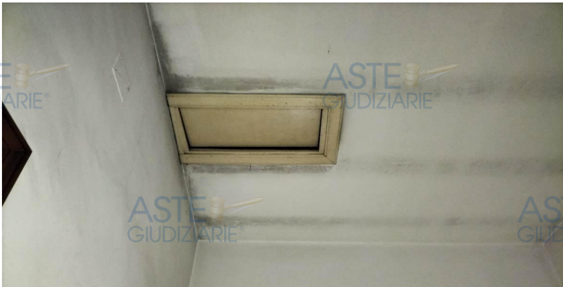
Botola d'accesso al soffitto
