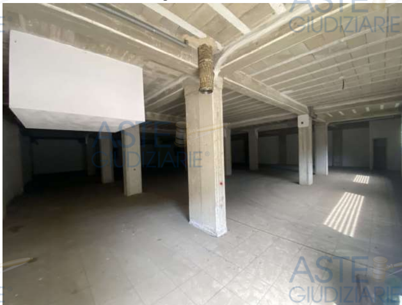
FOTO 18 a, b, c - interno locale deposito.
