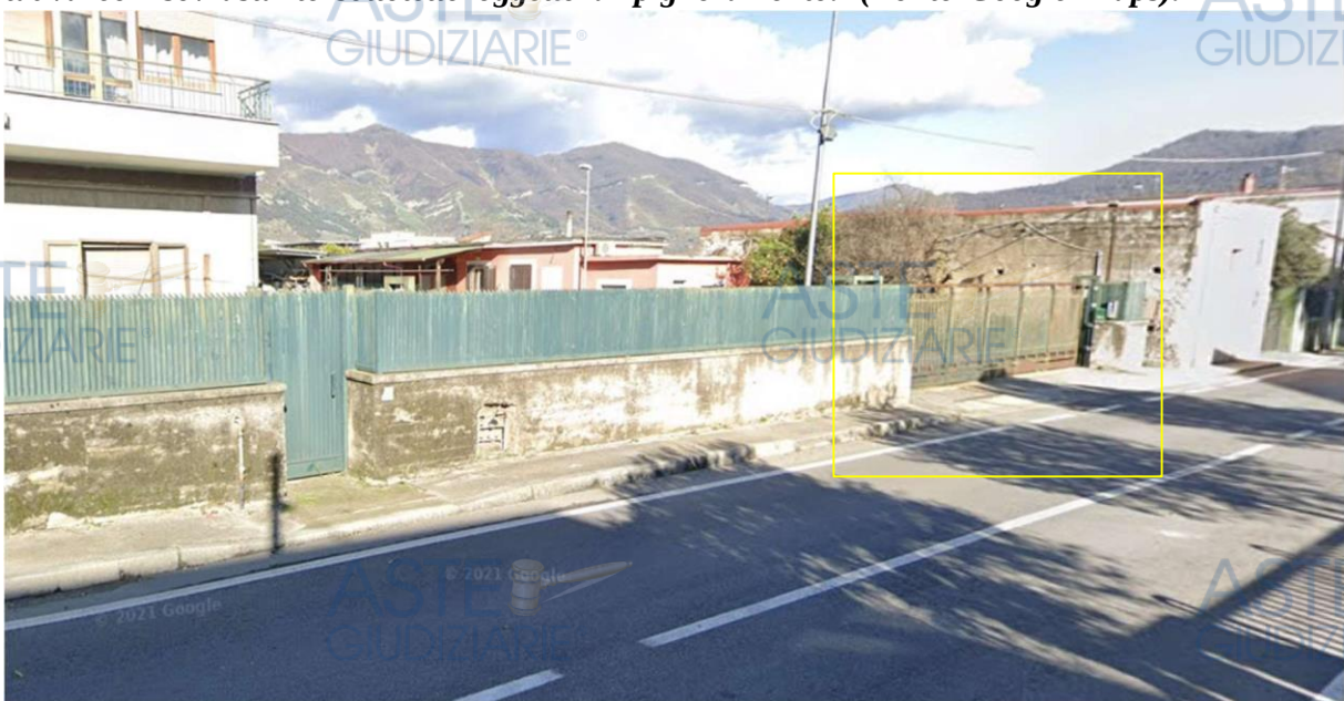
Vista dell'accesso carrabile al fabbricato P.Illa 1549, in giallo, e delle aree pertinenziali esterne, comuni anche alle altre unità immobiliari.
