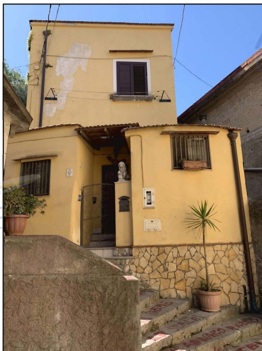
Vista prospetto principale, con esposizione Nord-Ovest, sullo slargo comunale di via Alfieri del fabbricato Part. 137 in cui ricade il Sub. 1, oggetto di pignoramento
