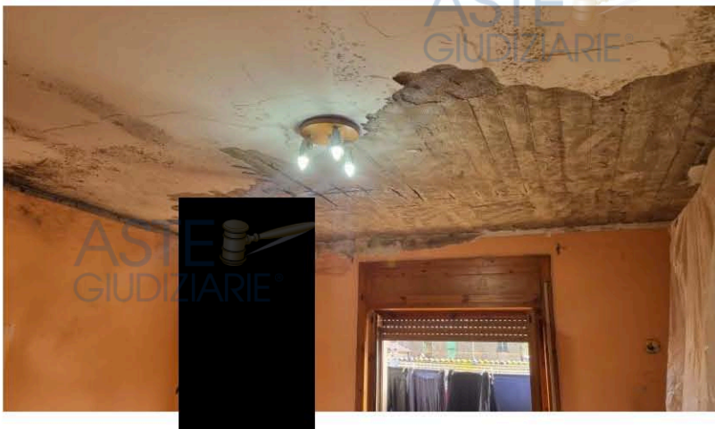
Foto n.2: fase lavorativa di spicconatura succielo camera da letto
