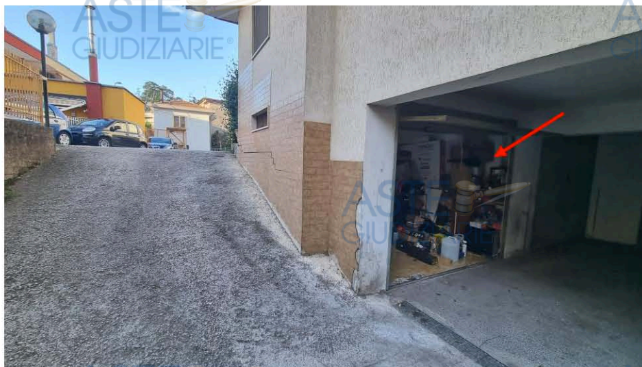
Foto n.30: discesa box-garage con indicazione del garage di proprietà dei debitori esecutati
