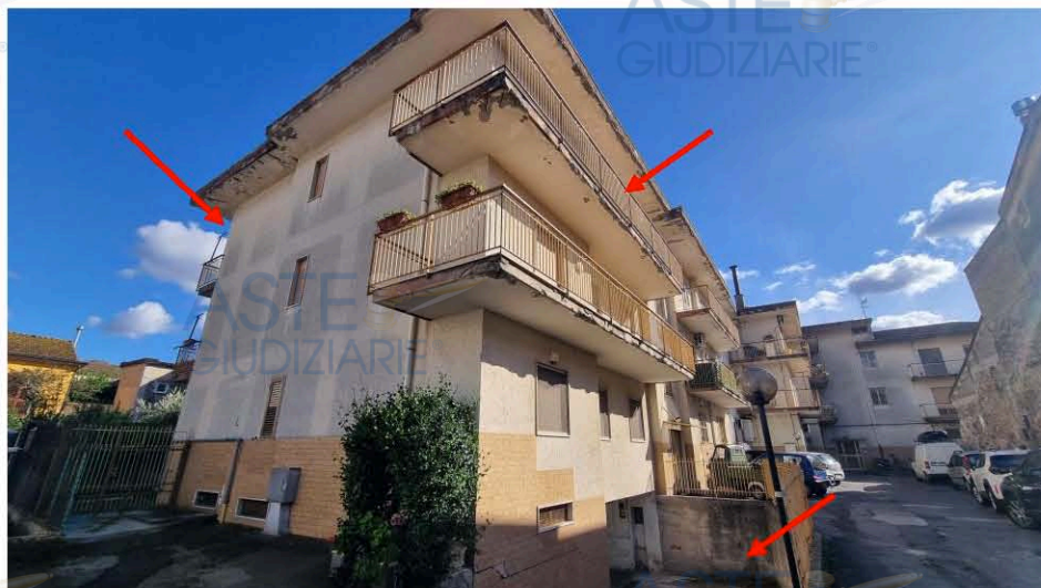
Foto n.2: stessa foto di quella precedente. Sono stati indicati l'appartamento al piano secondo e la rampa di accesso ai garage
