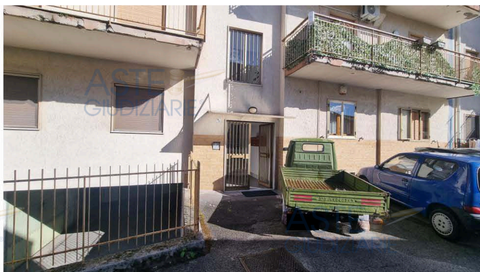
Foto n.3: portone di ingresso alla Scala A
