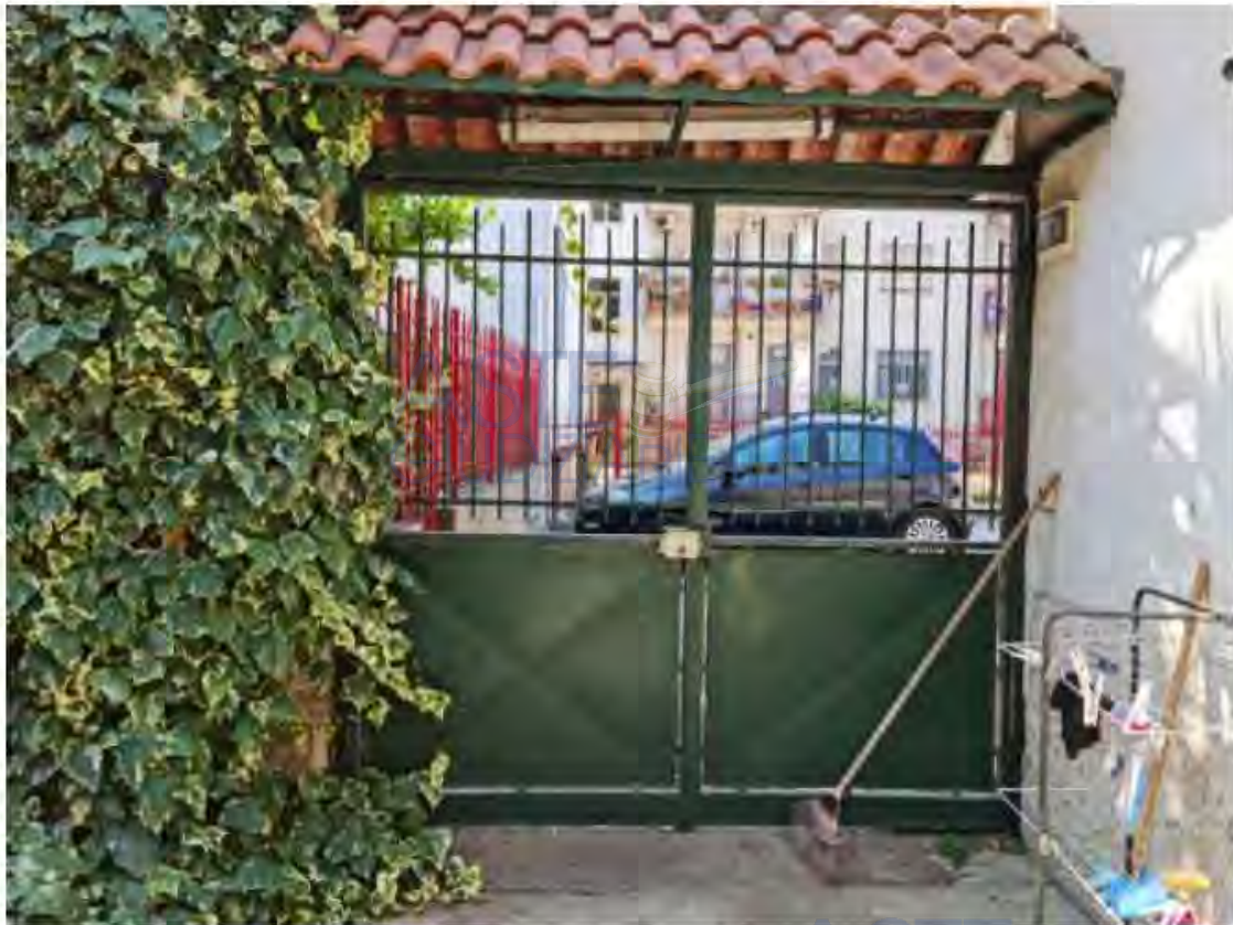
Veduta del varco d'accesso secondario a sud, in diretta prossimità del sub 5
