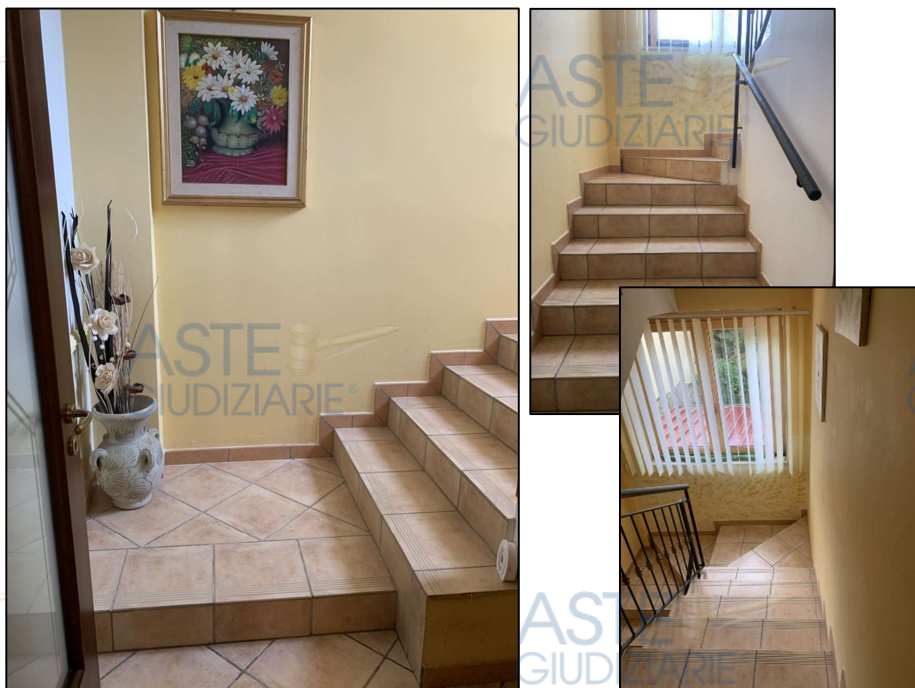
: Scala interna di collegamento dei vari impalcati .
