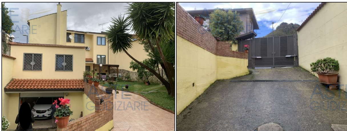
Vista della discesa tramite rampa al piano interrato che consente l'accesso al Box pertinenziale Sub. 5, al di sopra del box è visibile dall'esterno l'ambiente cucina illustrato in precedenza.
