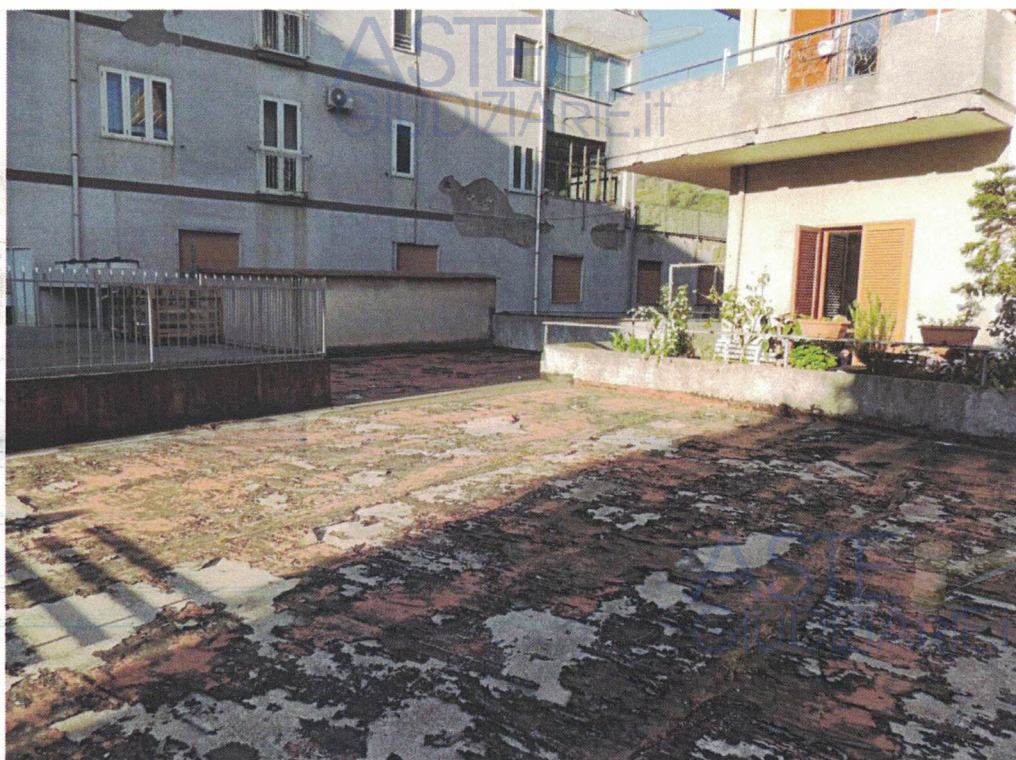
Lo stato di degrado e di usura della guaina applicata in passato per impermeabilizzare il terrazzo
