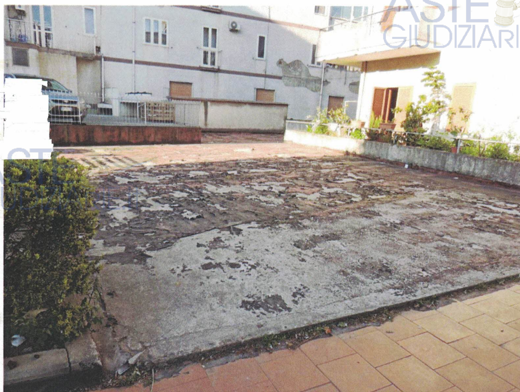
Lo stato di totale degrado del terrazzo condominiale di copertura al locale
