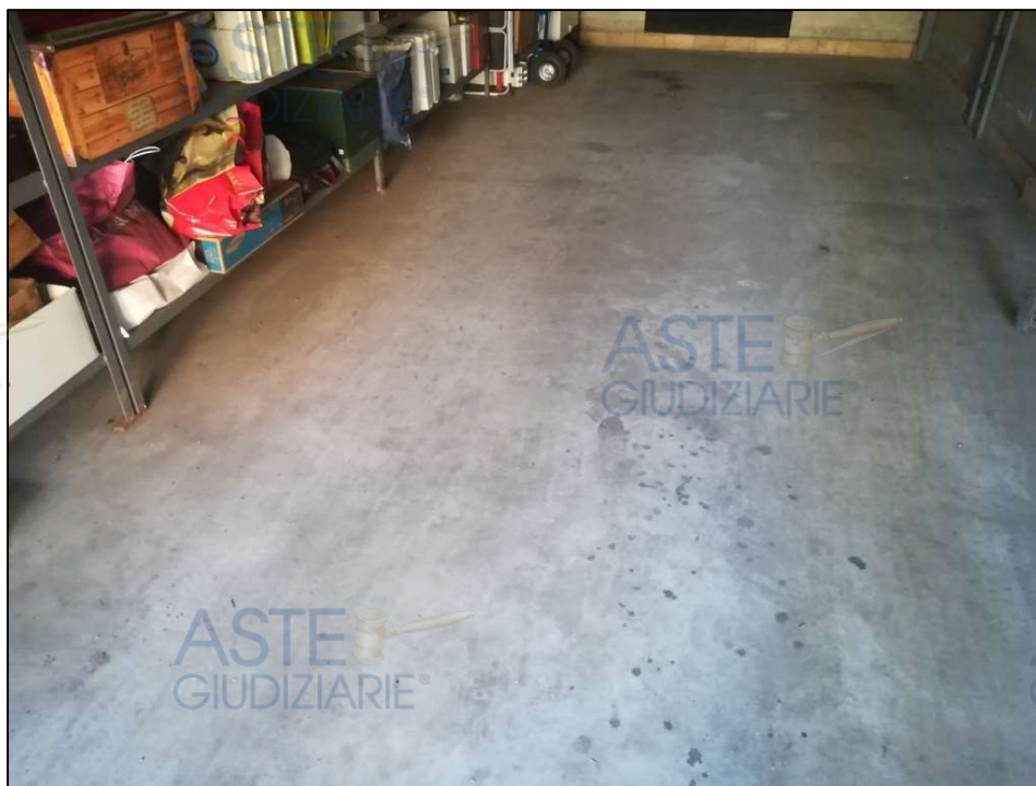
Foto 4: Particolare della pavimentazione realizzata con la tecnica della pavimentazione industriale di tipo cementizio.
