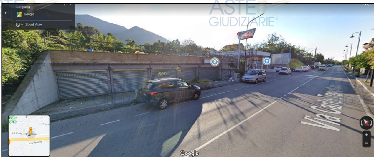
Vista 3D del fabbricato P.Ila 6674 – Lato Nord-Est. (Fonte Google Maps)
