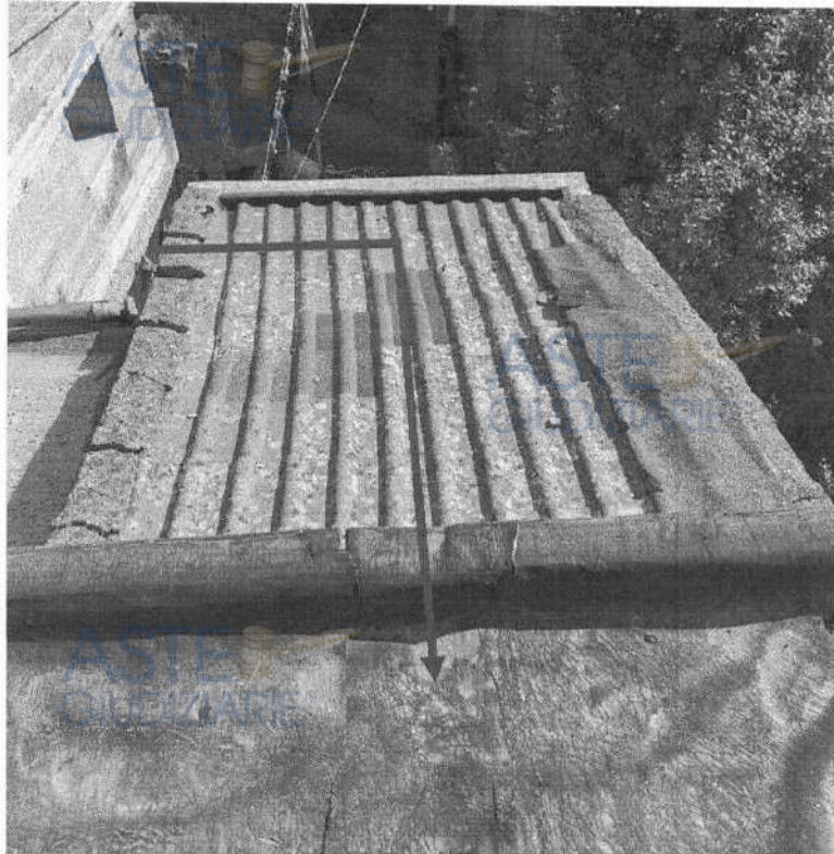
Sopralluogo del 28/06/2023. Tegolato in corrispondenza del bagno al piano primo e percorso di accesso al tetto
