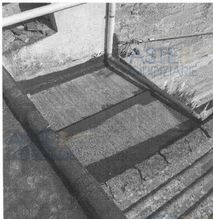
Sopralluogo del 28/06/2023. Botola, eventualmente da ripristinare, al fine di rendere più agevole l'accesso al tetto.
