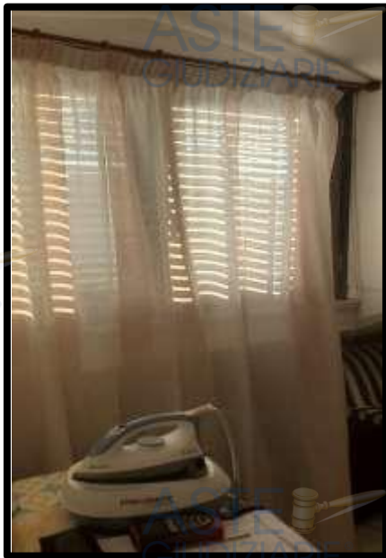
Foto n.40-Zona stenditoio-secondo piano-particolare abbaino
