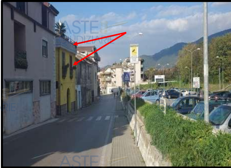
Foto n.1 fronte strada VIA FRATELLI NAPOLI,168
