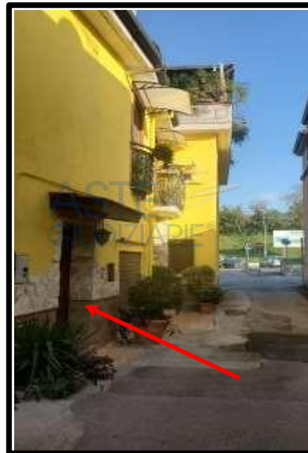
Foto n.5-Traversa Fratelli Napoli- Ingresso immobile-prospetto sud
