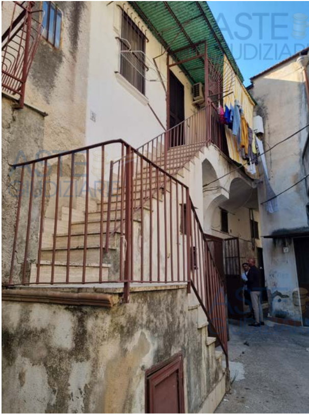
Foto 9 – Vano scala di accesso al P1
