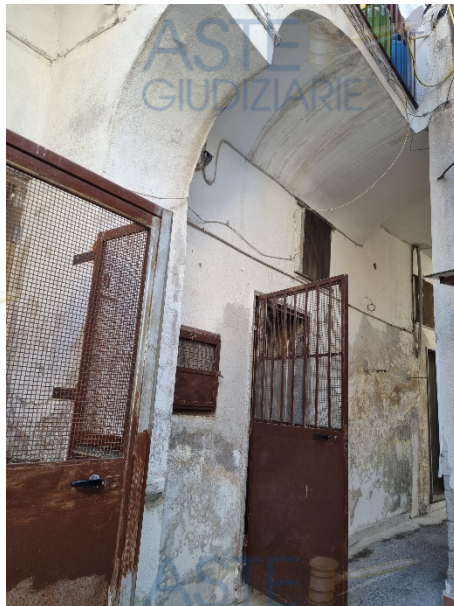
Esterno bene immobile – 26.08.2025
