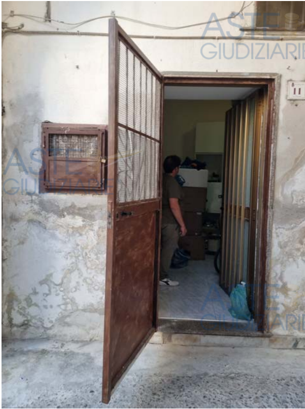
Foto 1 – Ingresso al piano terra
