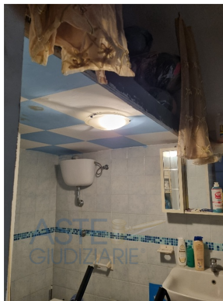
Vano bagno al PT completato – 26.08.2025
