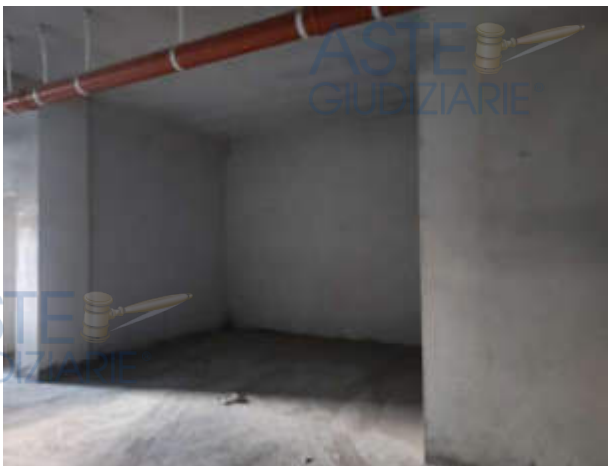
Fig. 24: Foto box sub 20 Lotto 2
