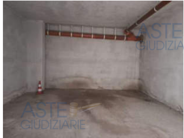
Fig. 36: Foto box sub 32 Lotto 5
