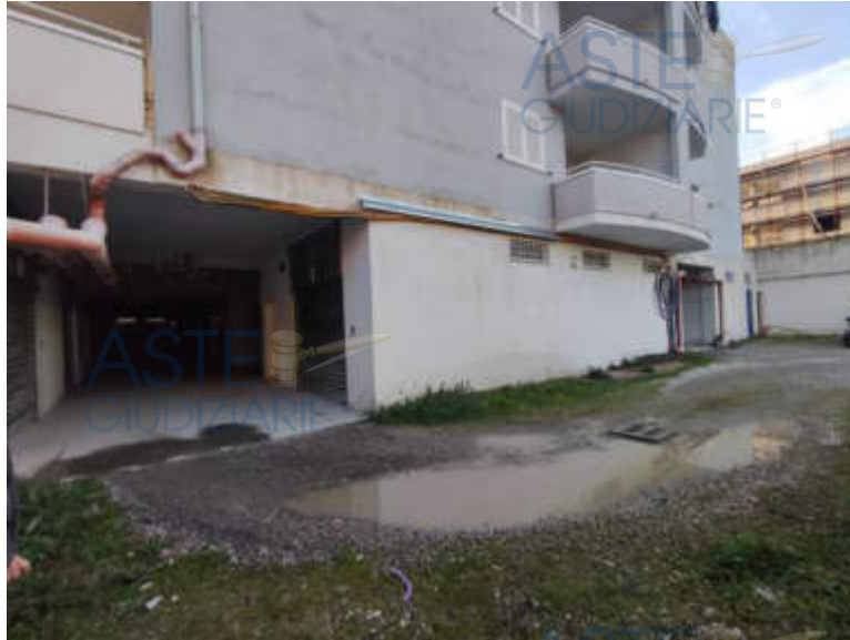
Fig. 15: Foto accesso box da via Dante Alighieri
