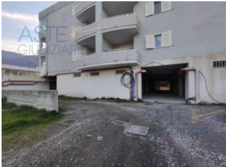
Fig. 14: Foto accesso box da via Dante Alighieri
