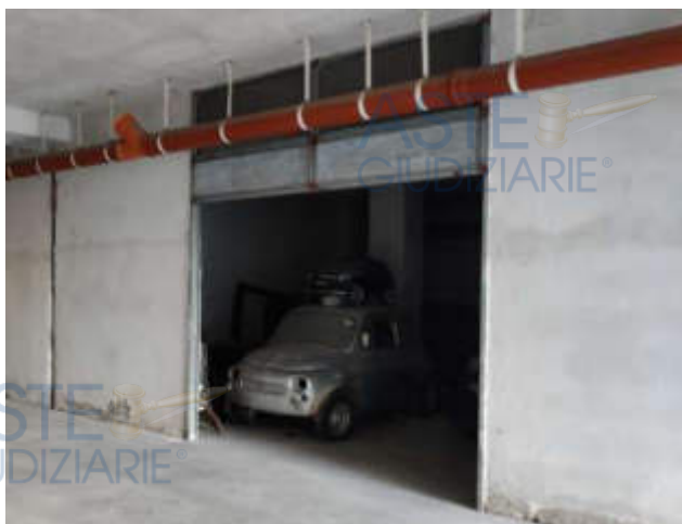
Fig. 44: Foto box sub 34 Lotto 7
