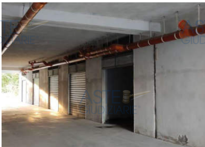
Fig. 39: Foto box sub 33 Lotto 6
