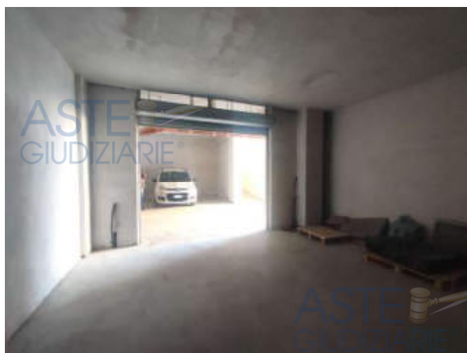
Fig. 22: Foto box sub 17 Lotto 1
