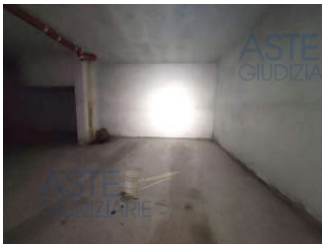
Fig. 28: Foto box sub 21 Lotto 3
