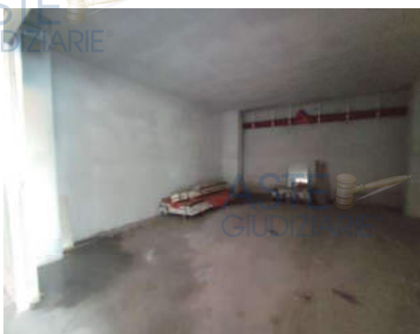
Fig. 41: Foto box sub 33 Lotto 6
