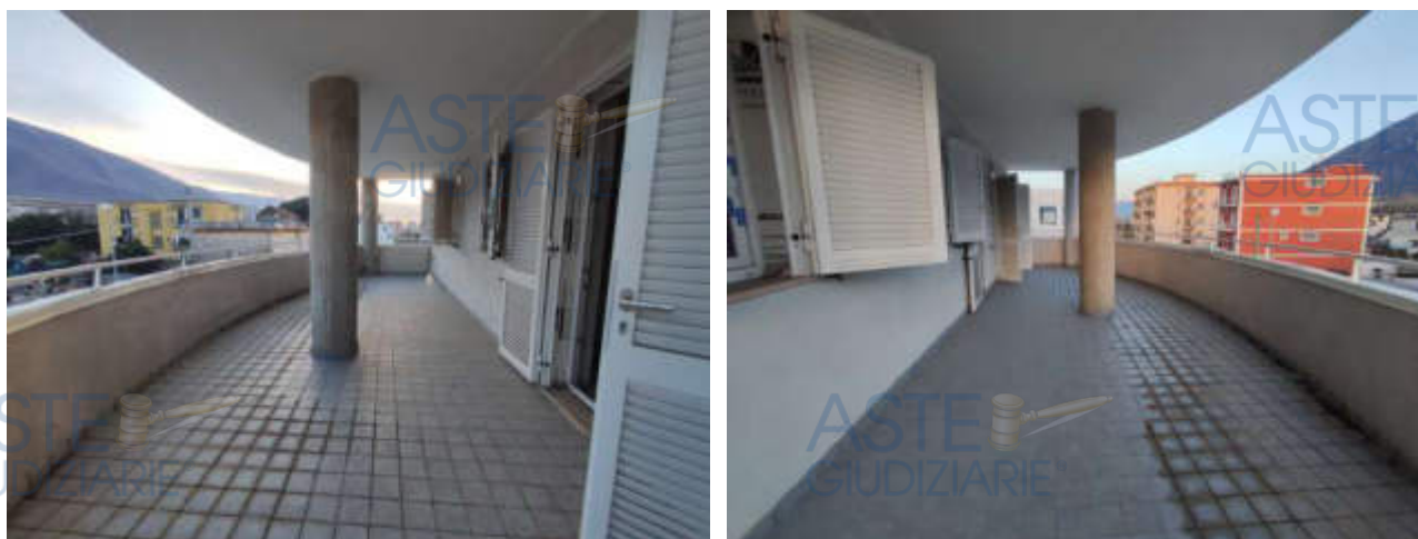
Fig. 71 e 72: Balcone 1 appartamento lotto 8
