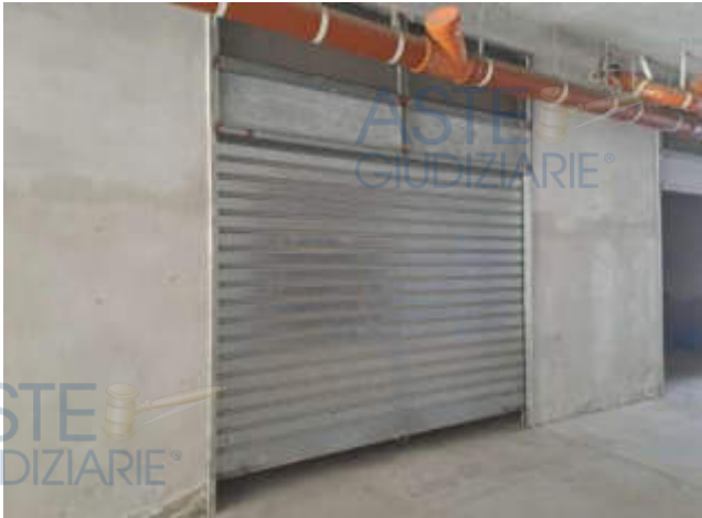
Fig. 35: Foto box sub 32 Lotto 5
