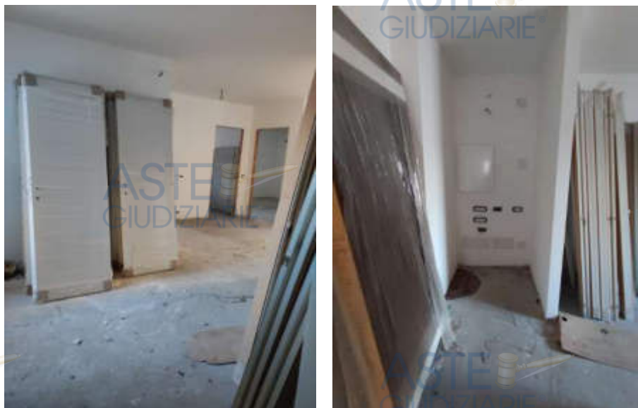
Fig. 59 e 60: Locale ingresso appartamento lotto 8
