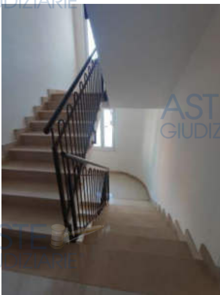
Fig. 53: Rampa scale edificio
