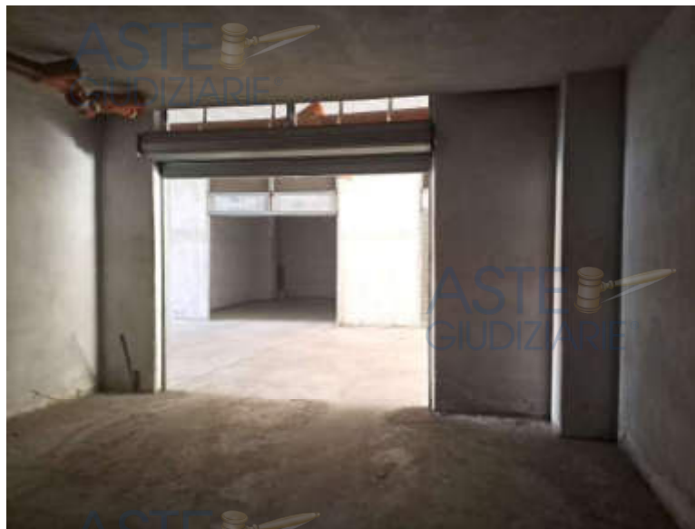
Fig. 37: Foto box sub 32 Lotto 5
