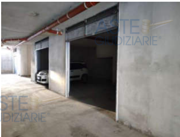
Fig. 27: Foto box sub 21 Lotto 3
