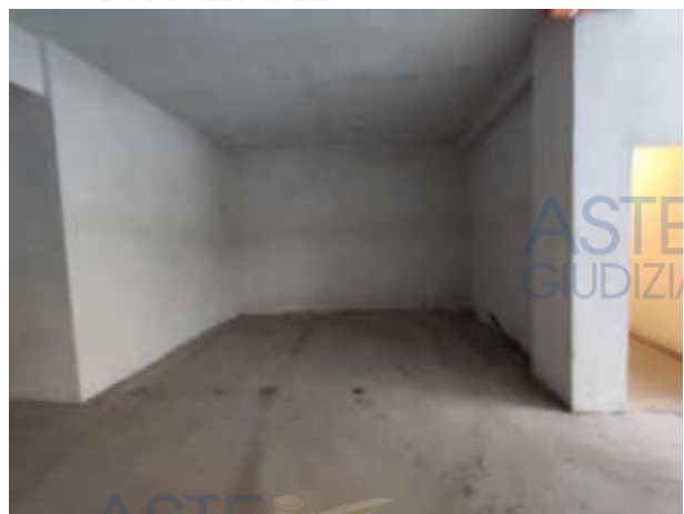
Fig. 33: Foto box sub 24 Lotto 4
