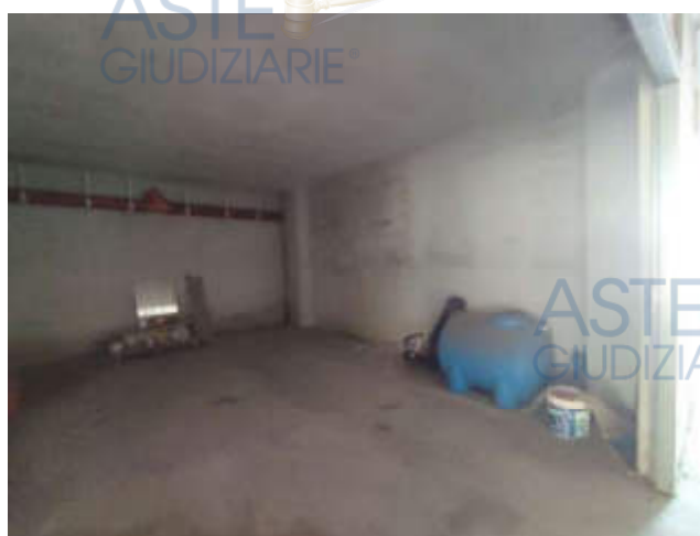
Fig. 42: Foto box sub 33 Lotto 6
