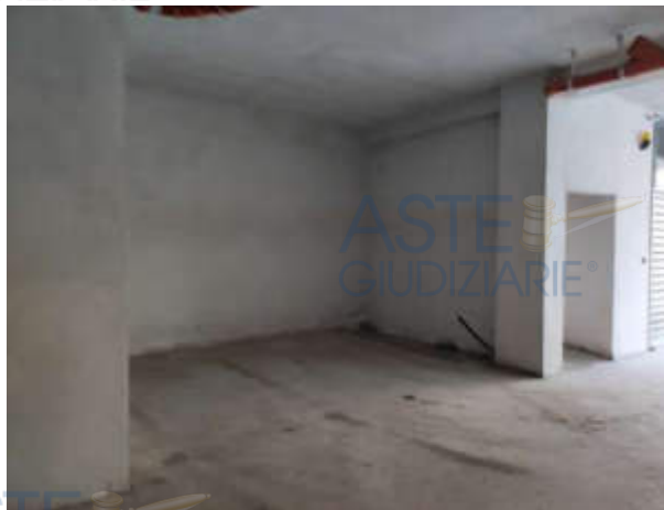
Fig. 32: Foto box sub 24 Lotto 4
