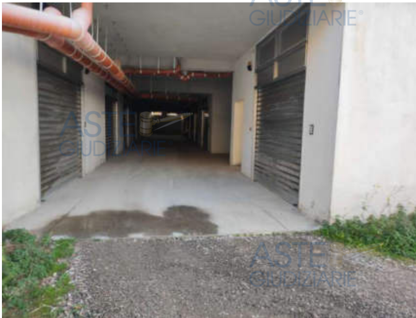
Fig. 16: Foto accesso box Corsia SUD
