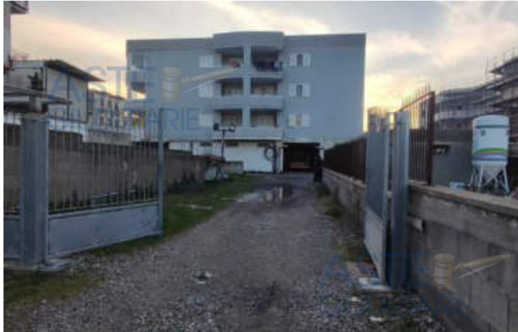
Fig. 13: Foto accesso box da via Dante Alighieri
