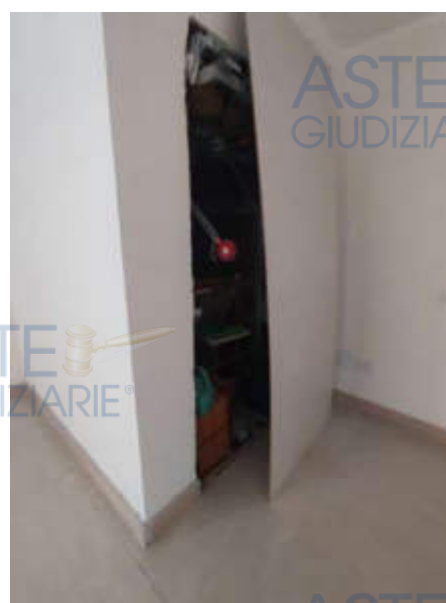
Fig. 56: Pianerottolo secondo Piano – vano ascensore
