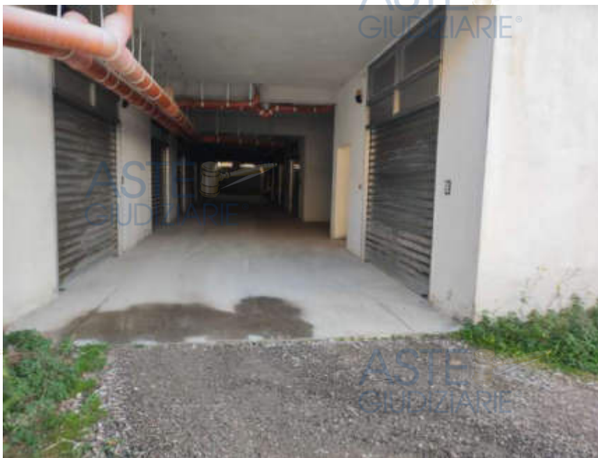
Fig. 16: Foto accesso box Corsia SUD
