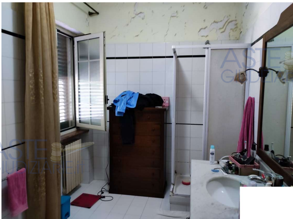
Fig. 144: WC 2 PT edificio p.lla 813 (da oper. perit)
