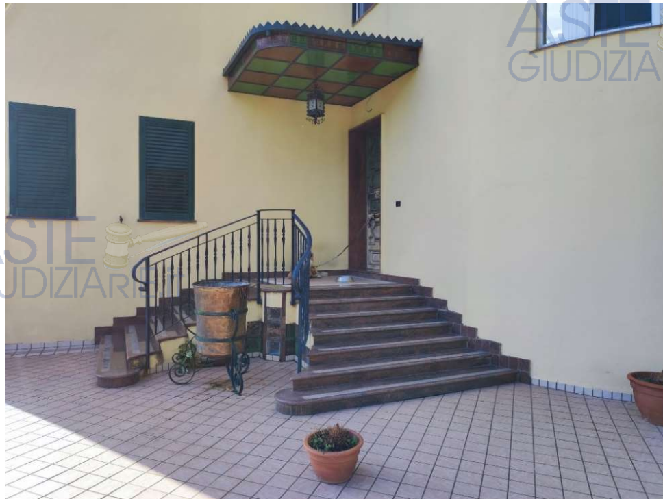
Fig. 138: Ingresso esterno PT edificio p.lla 813 (da oper. perit)
