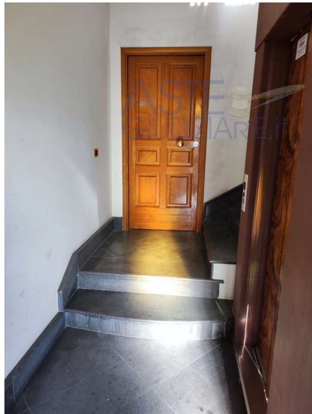
Fig. 52: Ingresso da scala locale 1 depos. Sub 13
