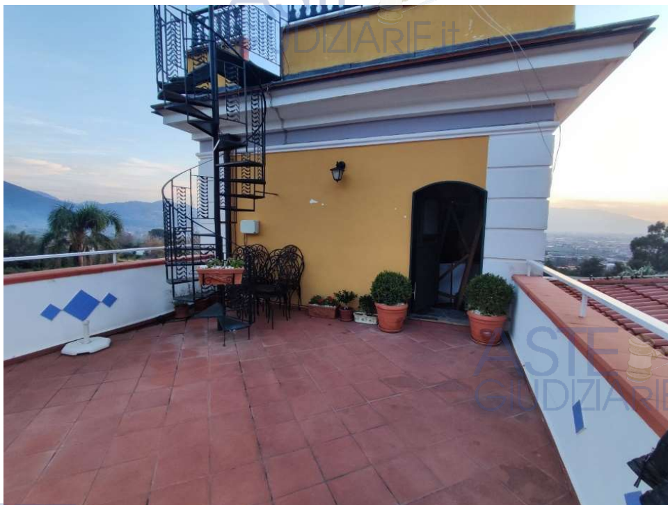
Fig. 111: Terrazzo al terzo piano apt P2 sub 15 (da oper. perit.)
