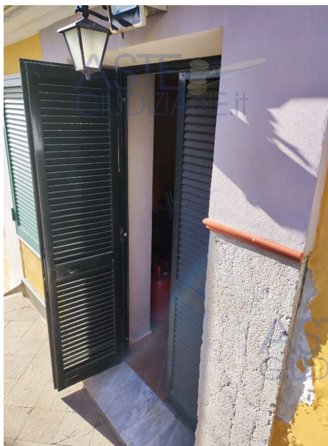
Fig. 57: Ingresso esterno locale 2 depos. Sub 13 (dalle oper. perit.)
