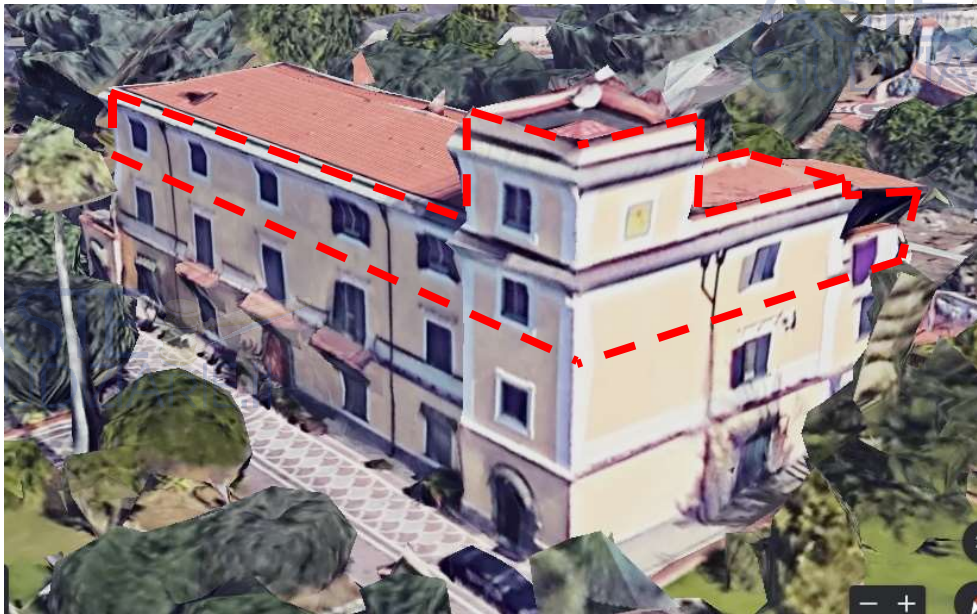
Fig. 75: Foto satellitare edificio con evidenza immobile pignorato sub 15 (al piano secondo)
