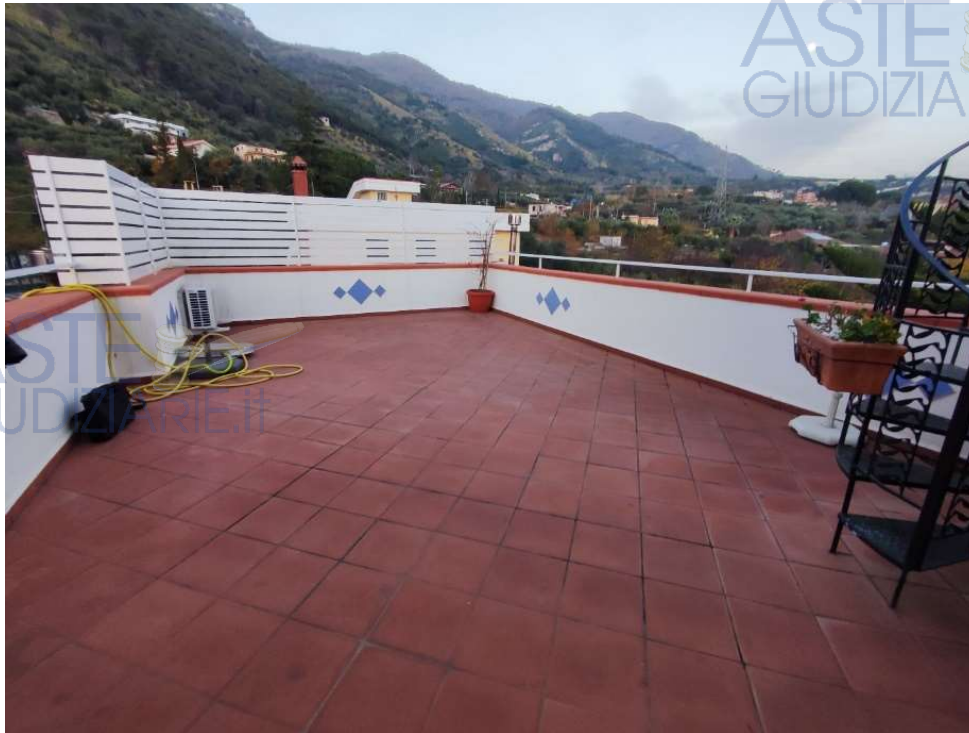
Fig. 110: Terrazzo al terzo piano apt P2 sub 15 (da oper. perit.)
