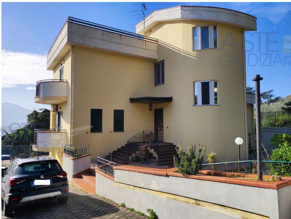
Fig. 123: Esterno edificio compendio pignorato p.lla 813 (dalle oper. perit.)
