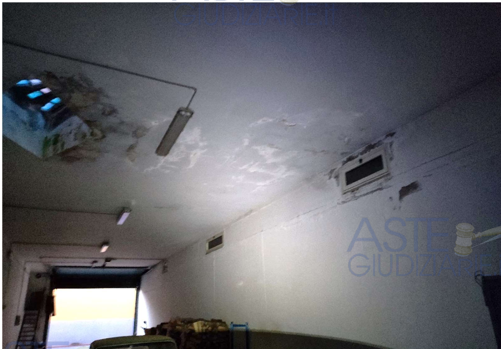
Fig. 69: Interno deposito Sub 14 (da oper. perit.)
