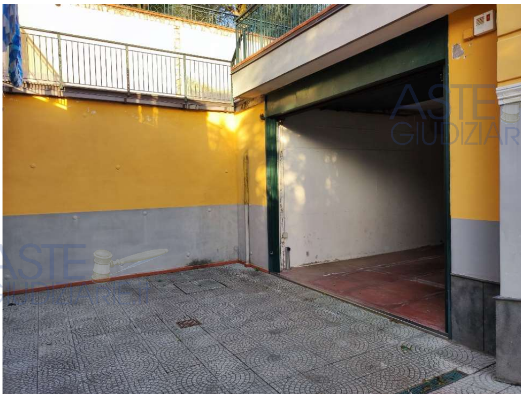
Fig. 66: Serranda ingresso deposito Sub 14 (da oper. perit.)
