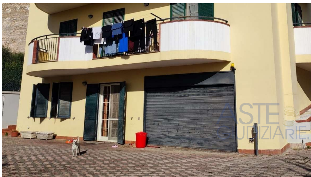
Fig. 128: Ingresso esterno piano seminterrato edificio p.lla 813 (dalle oper. perit.)
