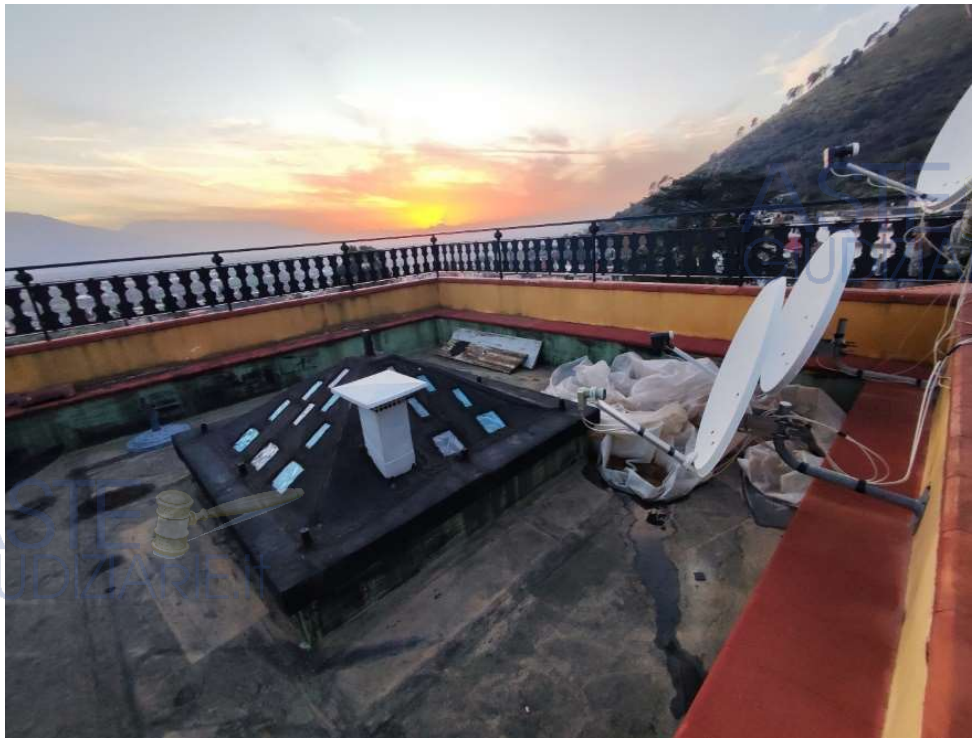
Fig. 114: Copertura torino quarto piano apt P2 sub 15 (da oper. perit.)
