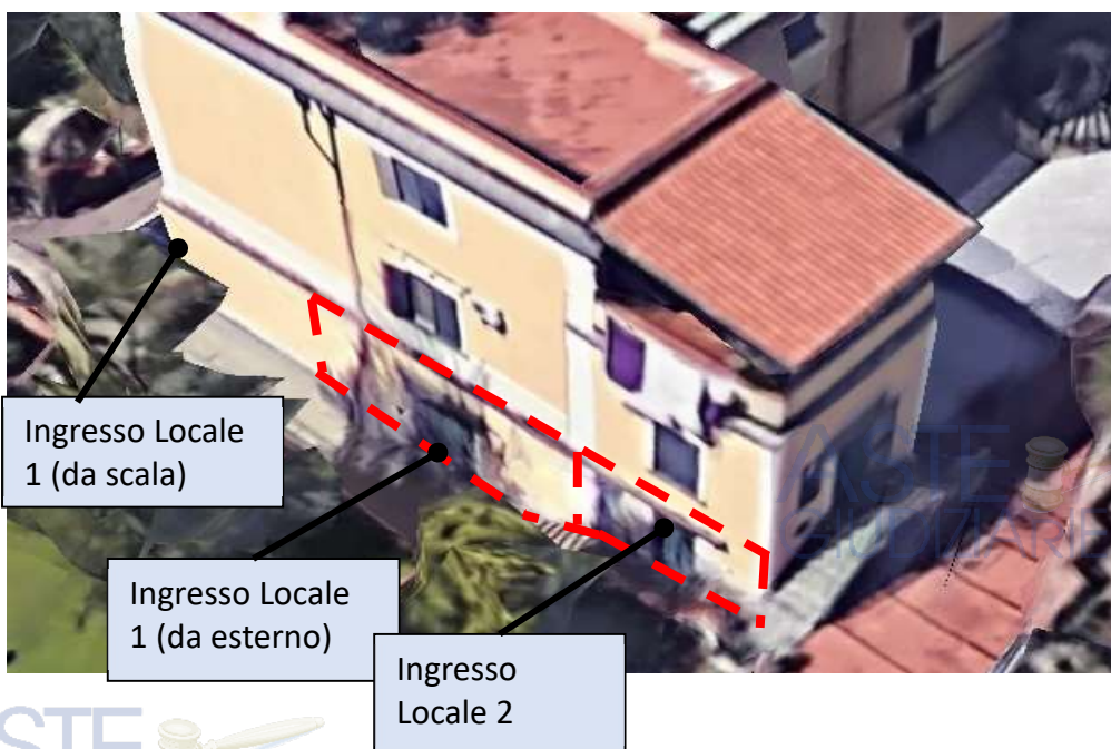
Fig. 50: Ingresso locali deposito Sub 13 (da Google map)
