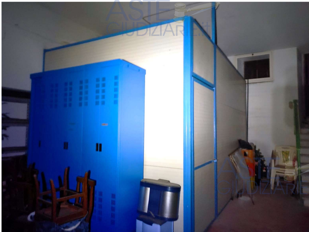
Fig. 71: Interno deposito Sub 14 (da oper. perit.)
