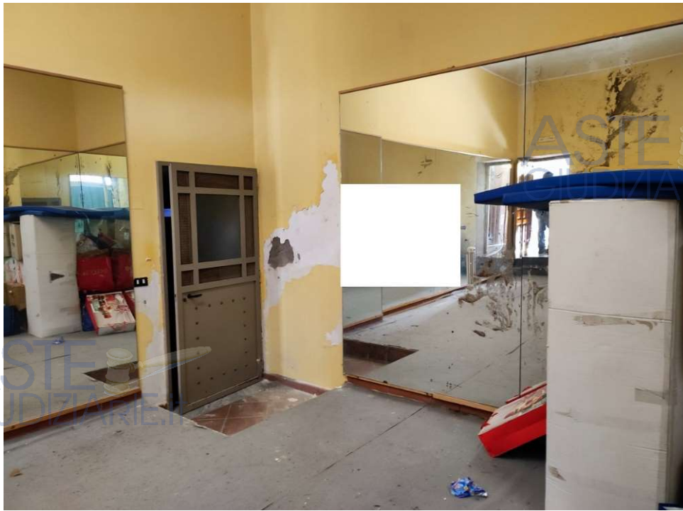
Fig. 54: Interno locale 1 depos. Sub 13 (dalle oper. perit.)
