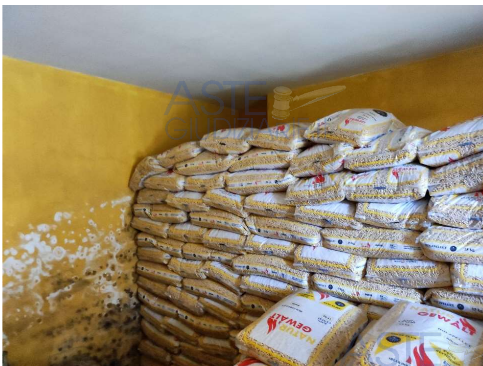
Fig. 59: Interno locale 2 depos. Sub 13 (dalle oper. perit.)
