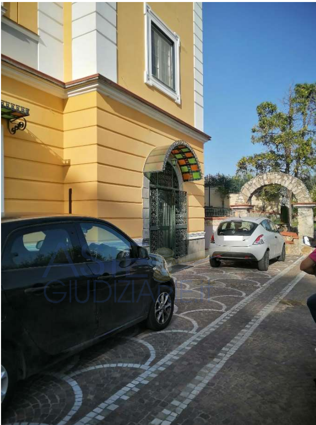
Fig. 51: Ingresso da scala locale 1 depos. Sub 13
