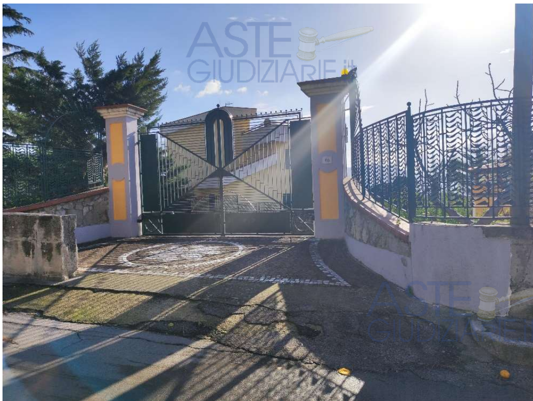
Fig. 178: Ingresso terreno pignorato P.lla 688 (da oper. perit.)
