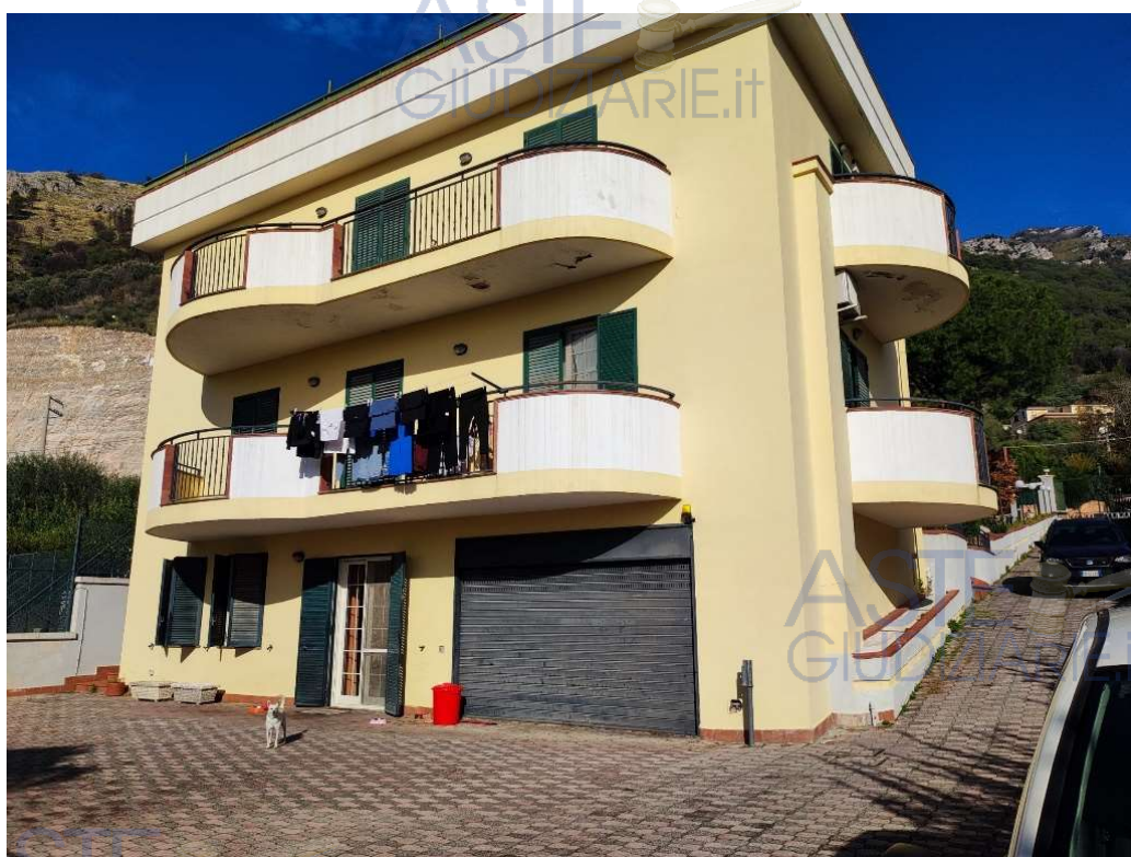
Fig. 124: Esterno edificio compendio pignorato p.lla 813 (dalle oper. perit.)
