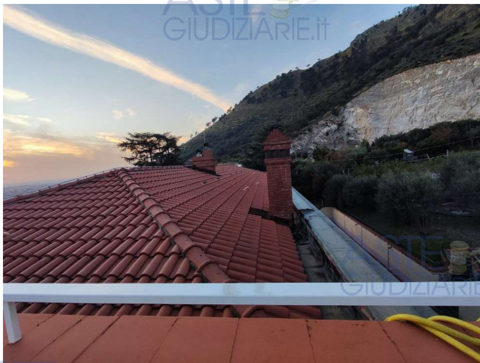
Fig. 113: Vista terrazzo e tetto al terzo piano apt P2 sub 15 (da oper. perit.)
