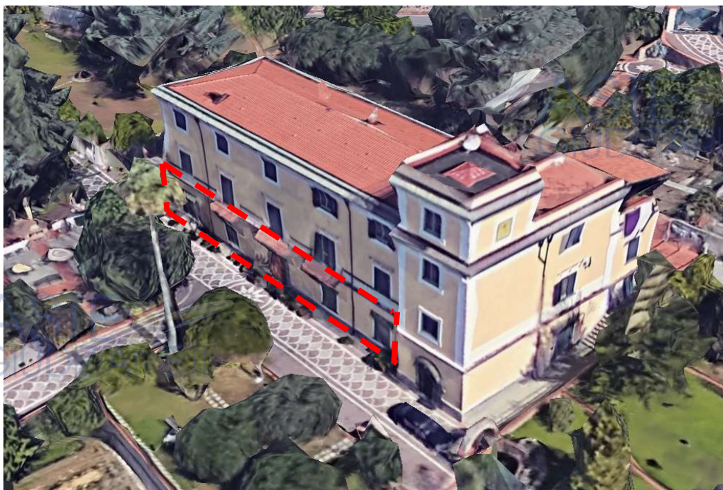
Fig. 18: Foto satellitare edificio con immobile pignorato sub 3 (tratteggiato in rosso apt piano terra).
