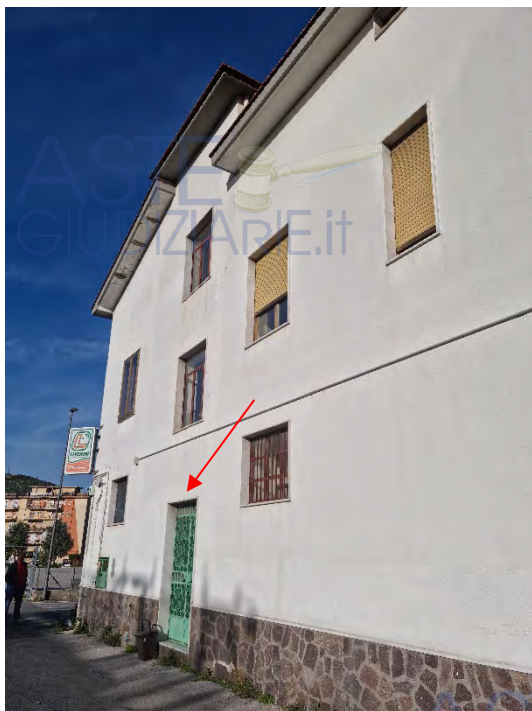
Ingresso al vano scala
