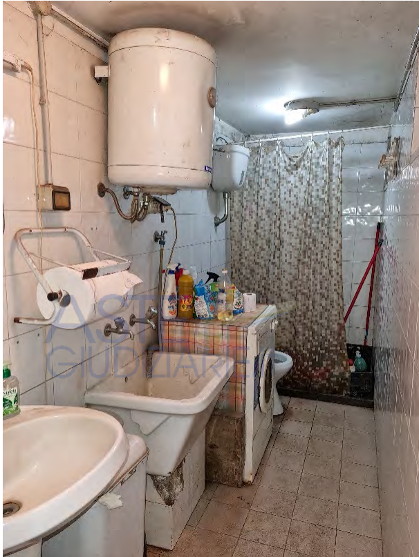
Wc abusivo PT
