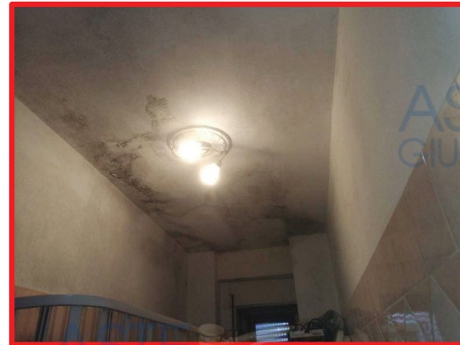
Altra visuale del bagno. Nella foto in basso, fenomeni di infiltrazioni d'acqua presenti sul solaio di copertura, provenienti dal locale al piano sovrastante.
