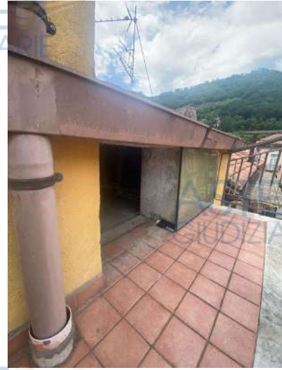
Foto n. 26: Balcone II P. fronte ovest con accesso al vano sottotetto
