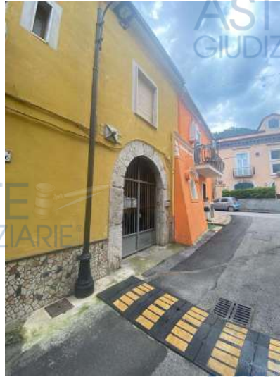
Foto n. 4: Portone di accesso alla corte comune da cui si accede al bene pignorato
