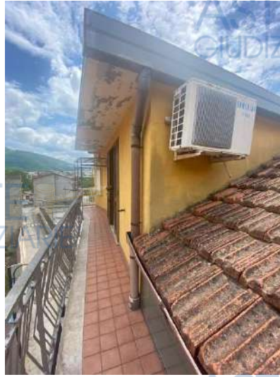
Foto n. 25: Balcone aggettante ad ovest in Piano sottotetto
