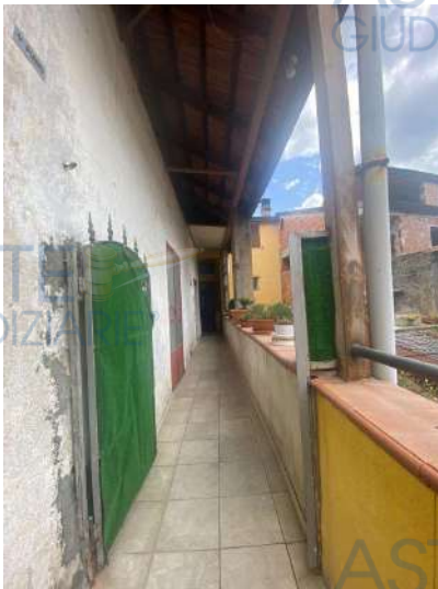
Foto n. 6: Corridoio comune di accesso all'immobile pignorato in I Piano
