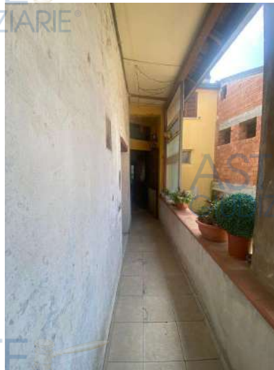
Foto n. 7: Corridoio comune di accesso all'immobile pignorato in I Piano
