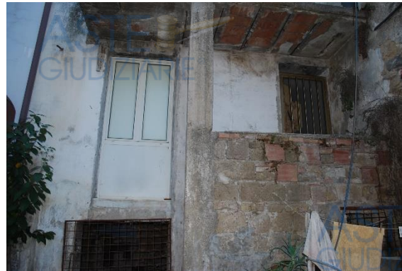
Foto 4 - prospetto est piano rialzato
