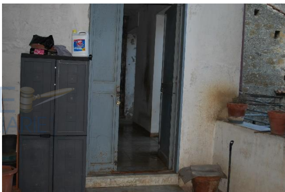
Foto 13 – piano primo – porta di accesso alla camera
