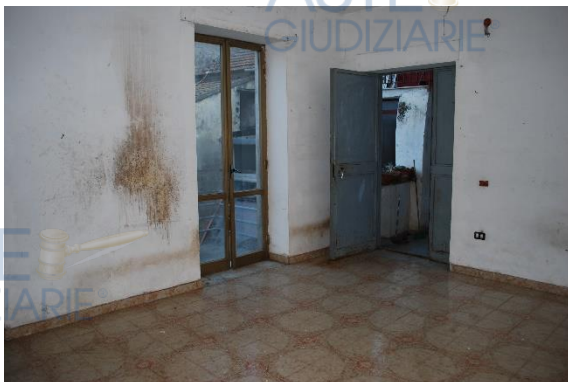
Foto 15 – piano primo - camera
