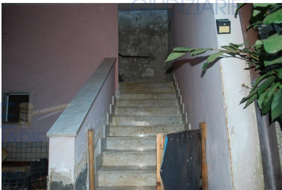
Foto 7 - scala comune prima rampa
