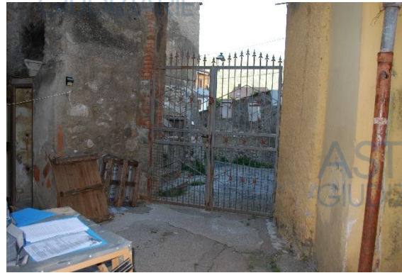
Foto 2 - cancello di ingresso alla corte
