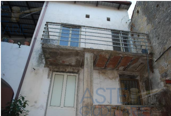
Foto 3 - prospetto est fabbricato
