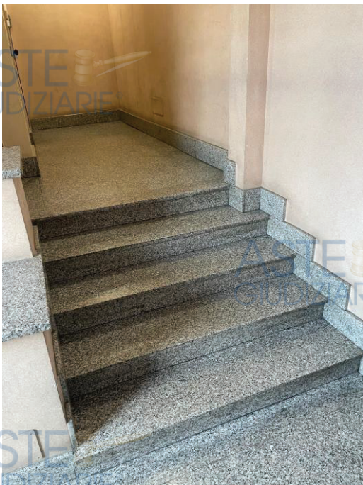
Foto 4 – vista del corpo-scala condominiale
