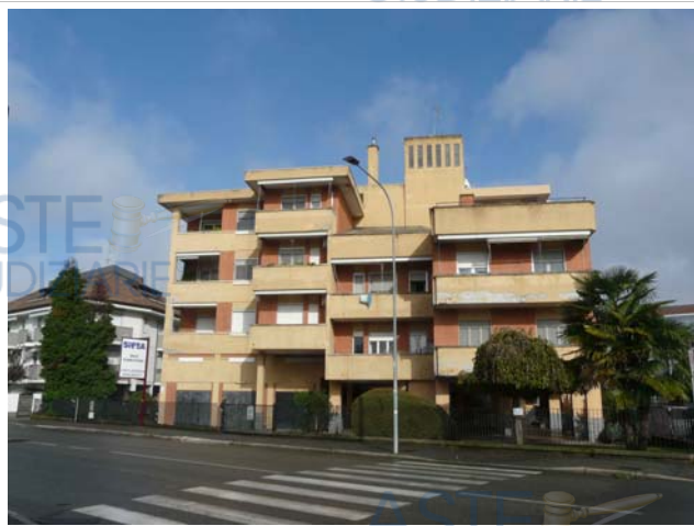
Inquadramento nel contesto urbano – prospetto verso Viale Kennedy
