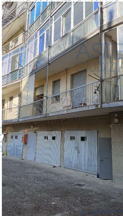
VISTA VERSO CORTILE RETROSTANTE
