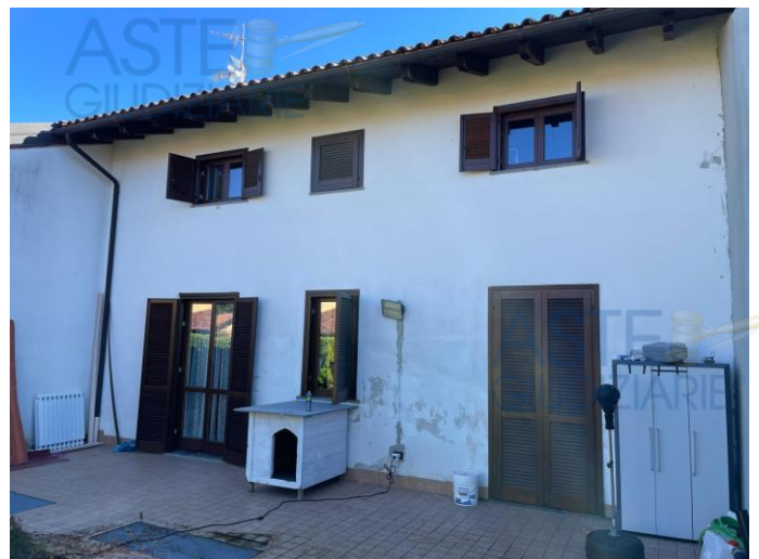
Foto 3 – vista del fronte di nord
