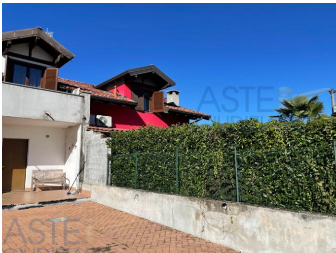
Foto 4 – vista del confine verso est
