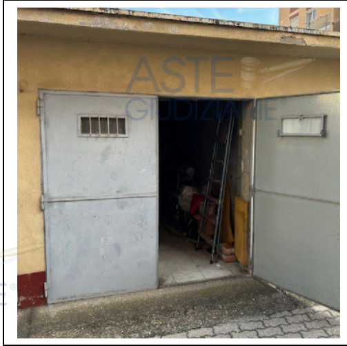
Fig. 78 part. 482 sub.4 Destinazione: AUTORIMESSA Foto: vista da corte interna.
