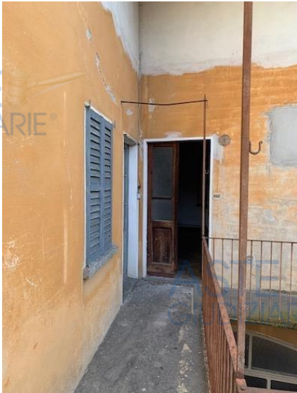
INGRESSO DAL BALCONE
