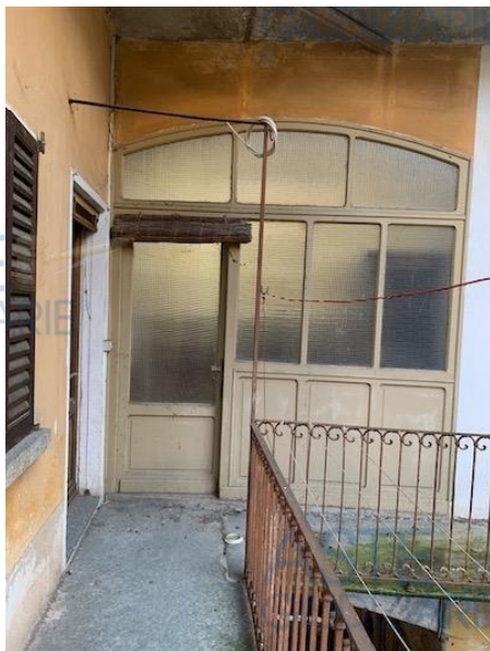
INGRESSO DAL BALCONE
