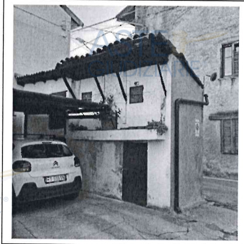
Fig. 61 part. 934 sub. Destinazione: magazzino Foto: vista da corte interna.
