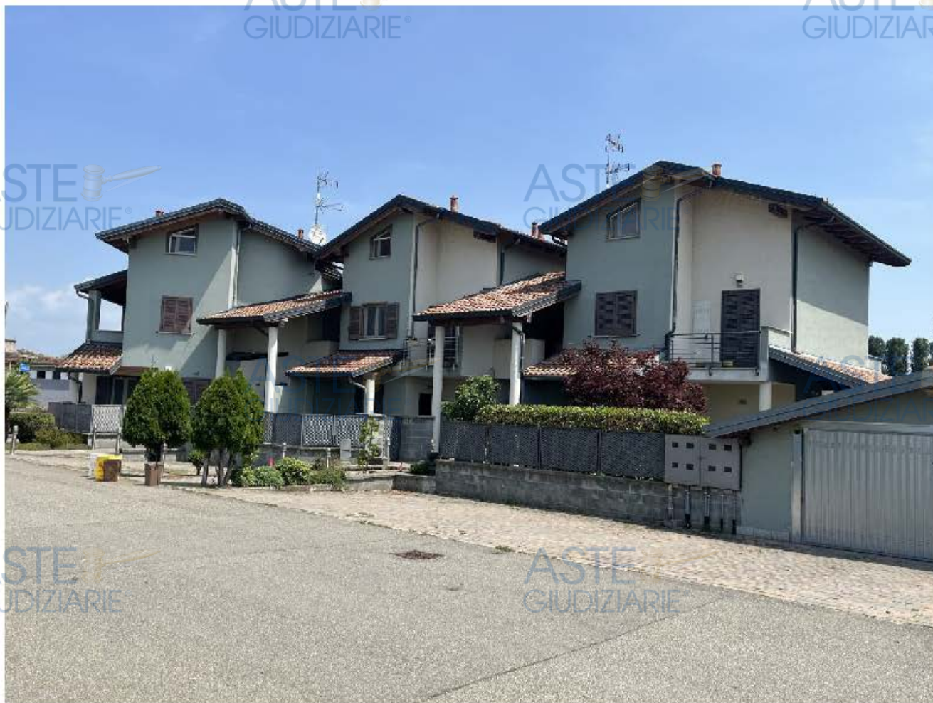
Vista d'insieme del fabbricato da viale Roma – lato Sud-Est
