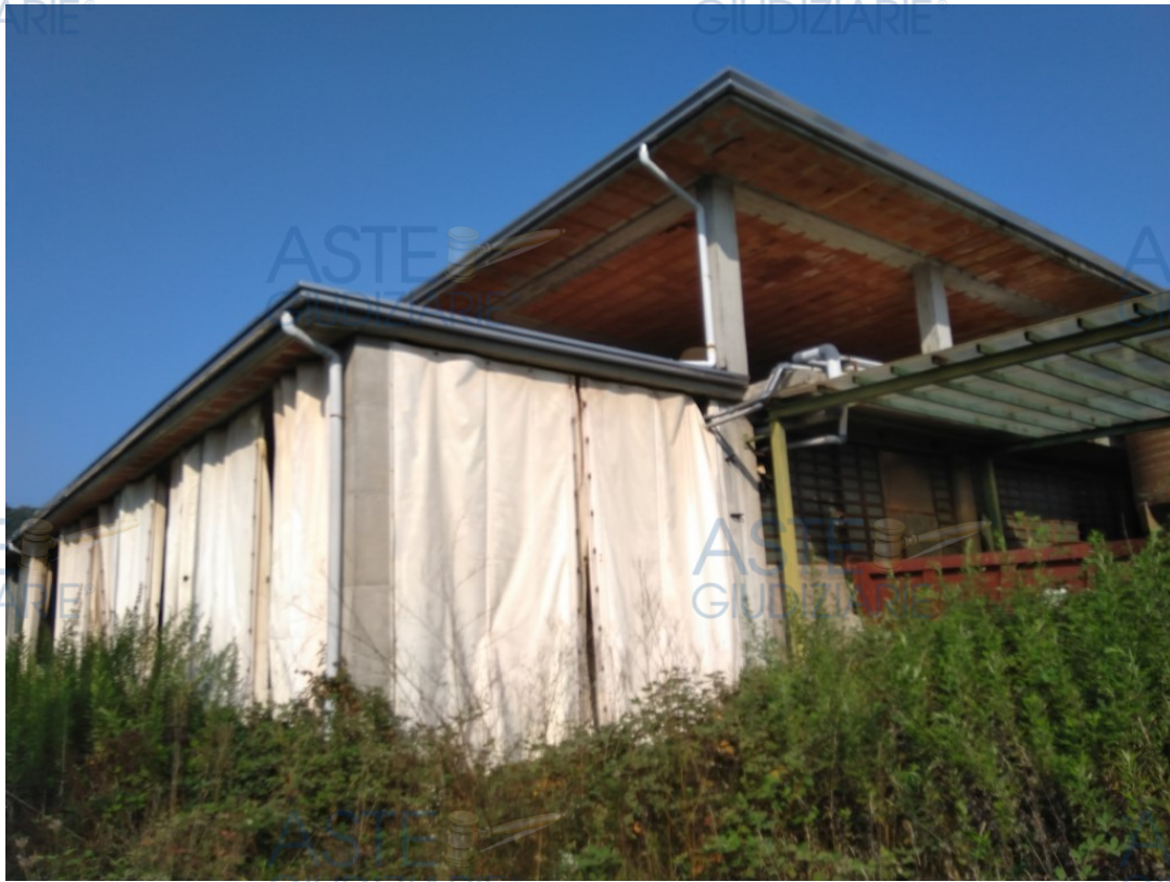
Vista esterna: capannone angolo Sudest
