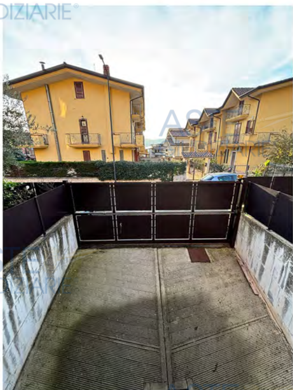
Vista rampa di accesso al garage
