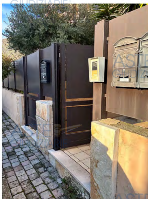
Vista cancello di accesso allo stabile
