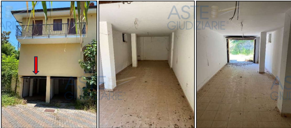
Figura 7. Rilievo fotografico locale garage (subalterno 10).
