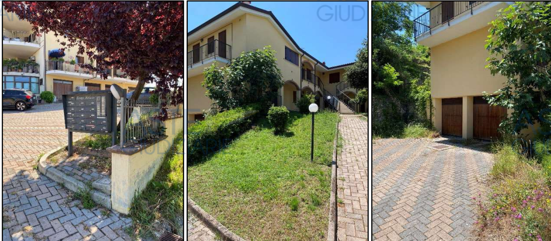
Figura 4. Ingresso "Borgo Antico", fabbricato prospetto nord e prospetto est.
