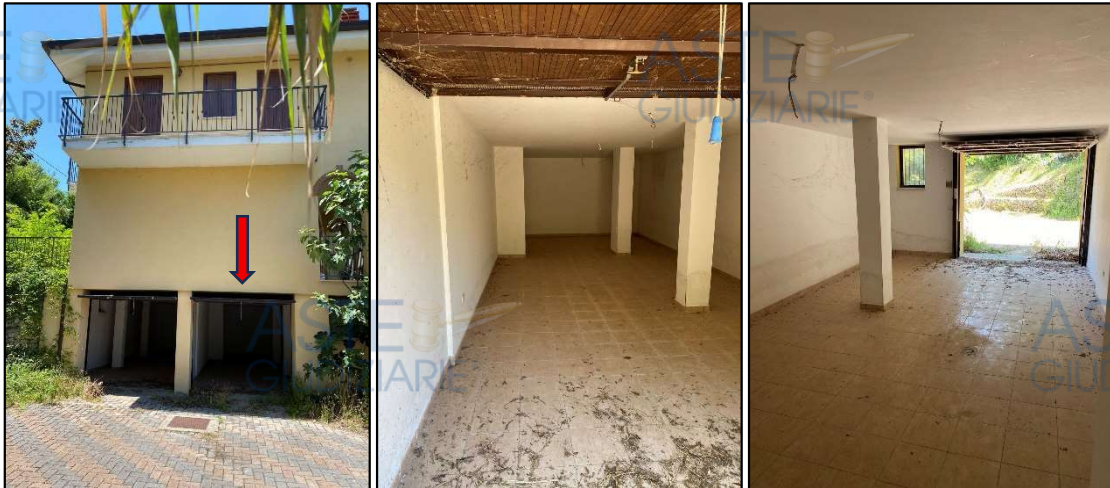
Figura 6. Rilievo fotografico locale garage (subalterno 9).
