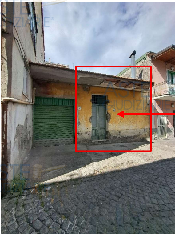
Unità immobiliare p.lla 208
