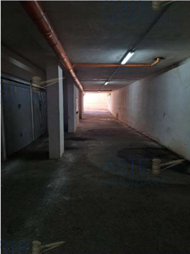
Vista interna del piano interrato
