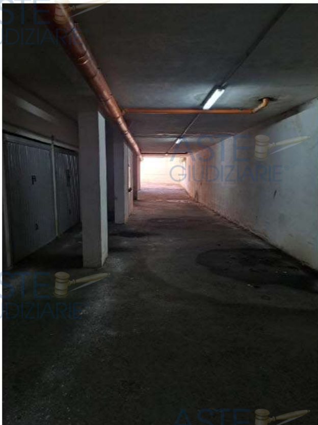
Vista interna del piano interrato
