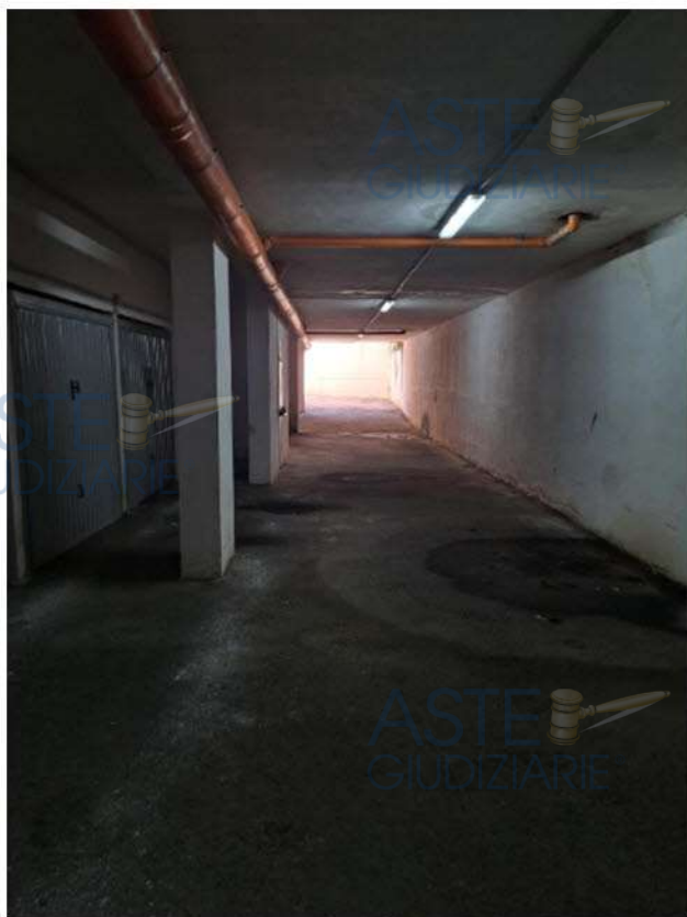
Vista interna del piano interrato
