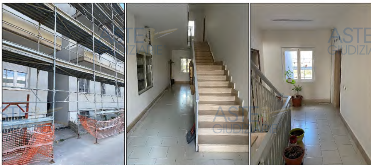
FIGURA 11. FABBRICATO A, SCALA C.
