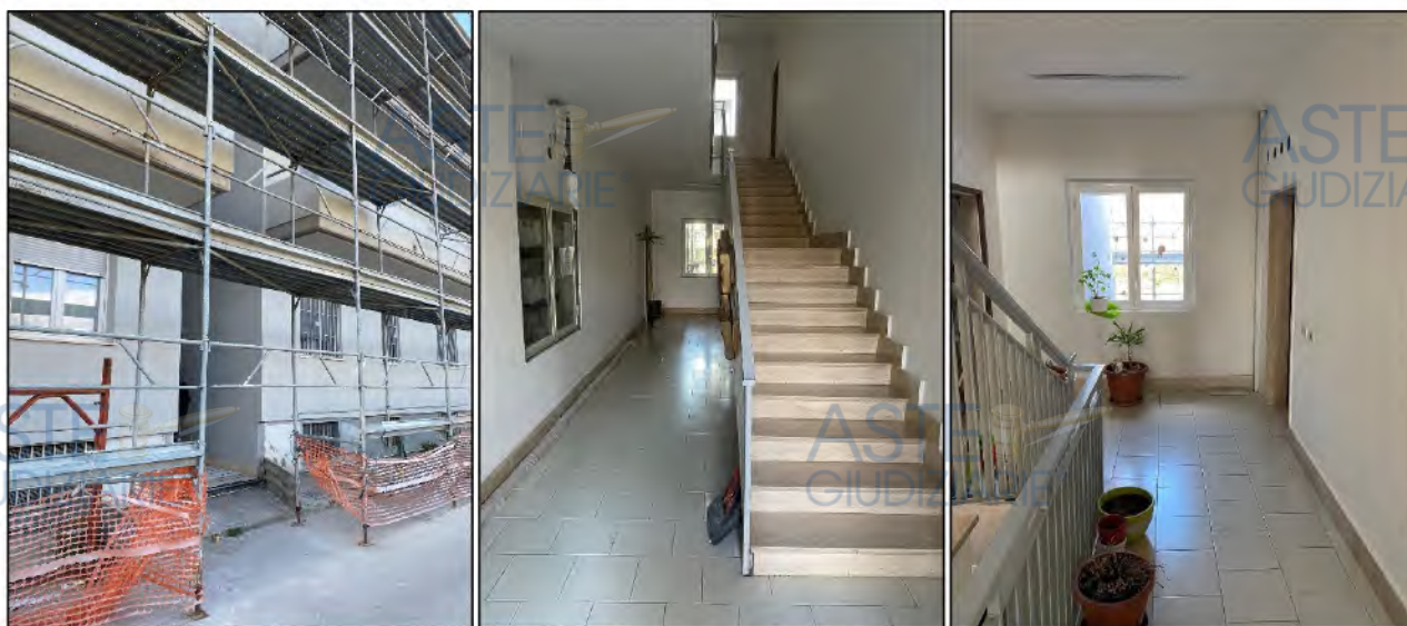
FIGURA 4. FABBRICATO A, SCALA C.
