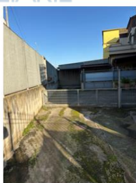
Foto n. 43 - Corte pertinenziale verso il cortile comune sub 101
