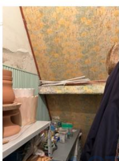
Foto n. 9 - Ripostiglio sotto la scala
