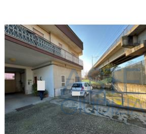
Foto n. 48 - Corte pertinenziale dal cortile comune sub 101
