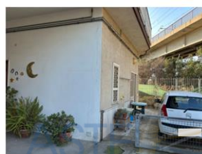
Foto n. 45 - Corte pertinenziale dal cortile comune sub 101
