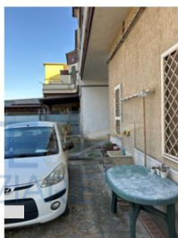
Foto n. 44 - Corte pertinenziale verso il cortile comune sub 101
