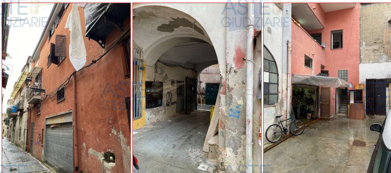
FIGURA 5. RILIEVI FOTOGRAFICI FABBRICATO (ESTRATTO ALLEGATO C-1).
