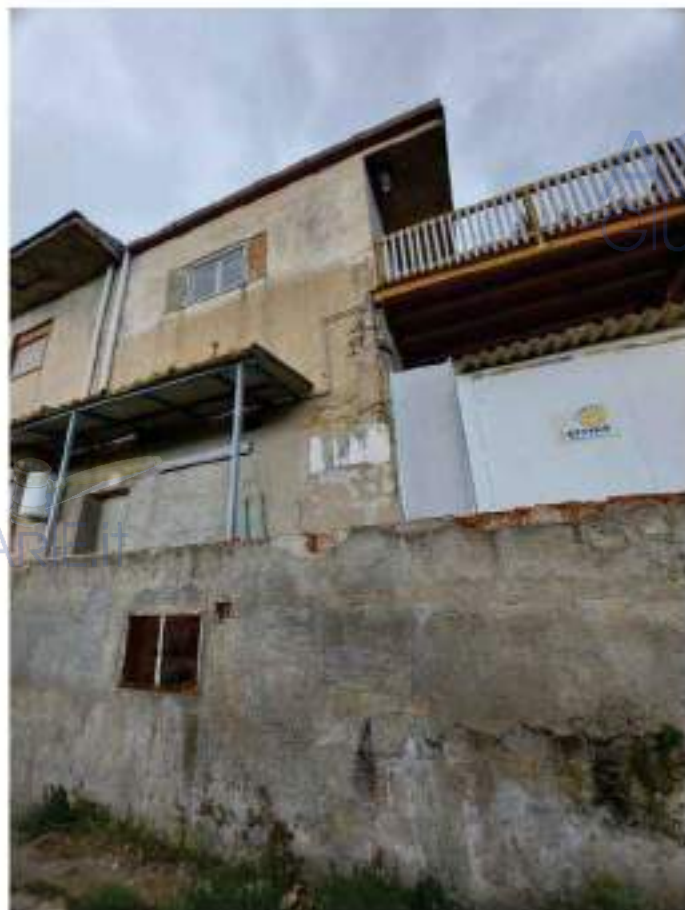
Foto - IMMOBILE 3 Prospetto EST
