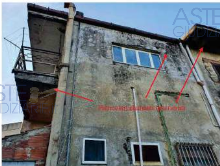
Foto - IMMOBILE 3 Prospetto EST
