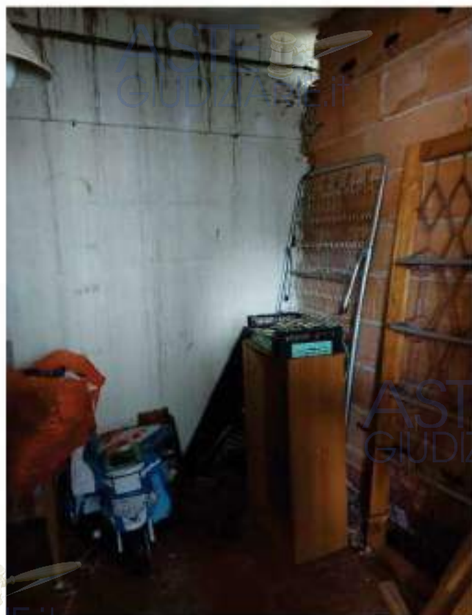
Foto - IMMOBILE 3 Depostiglio
