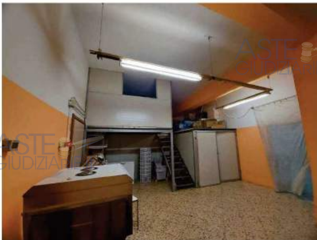
Foto - IMMOBILE 5 Struttura precaria
