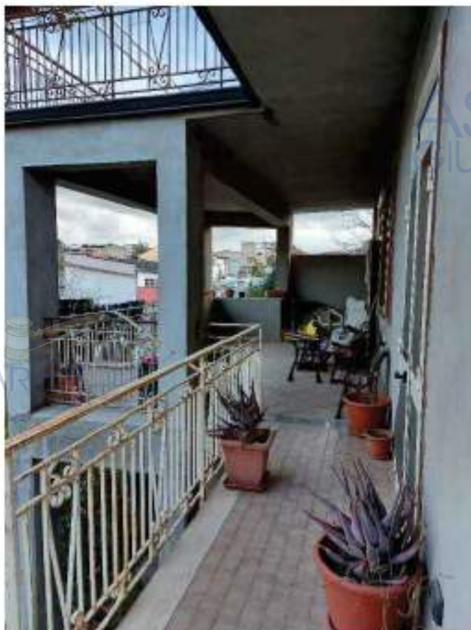
Foto - IMMOBILE 1 Terrazzo
