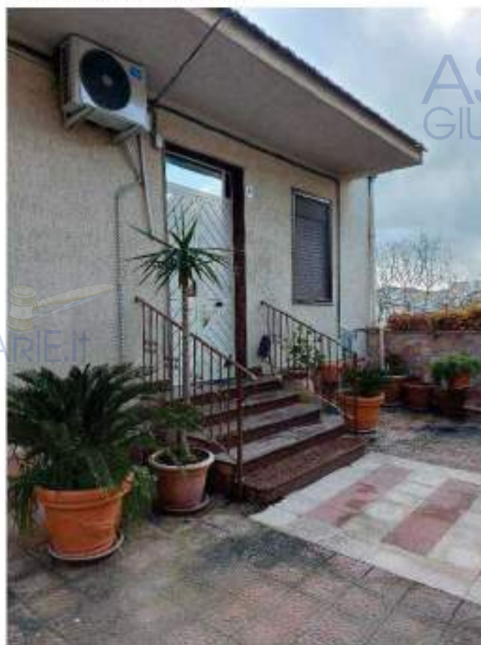
Foto - IMMOBILE 1 Ingresso da corte comune
