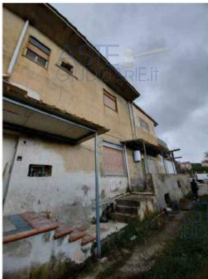
Foto - IMMOBILE 3 Prospetto EST
