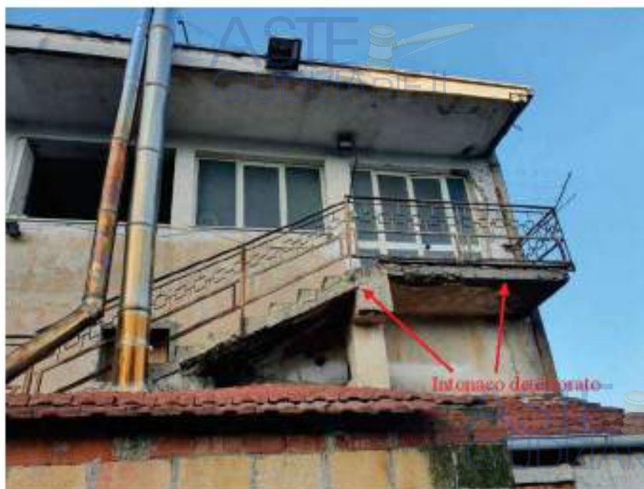
Foto - IMMOBILE 3 particolare scala armata
