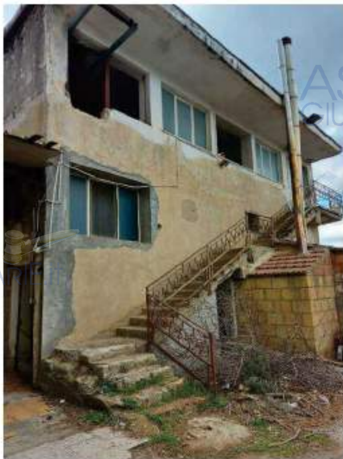
Foto - IMMOBILE 3 Scala accesso lato SUD
