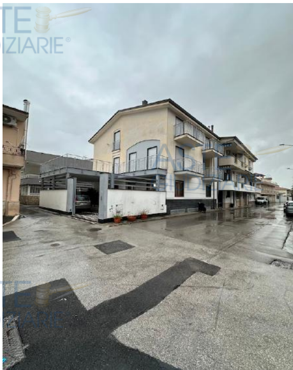
Foto n.1 – Panoramica fabbricato da Via Roma
