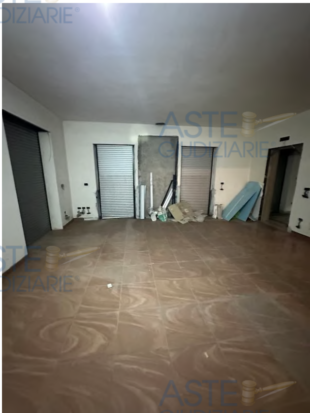
Foto n.7 – Particolare duplex sub 4
