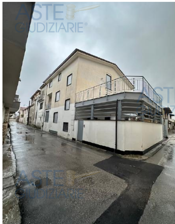
Foto n.2 – Panoramica fabbricato da Vico Benevento
