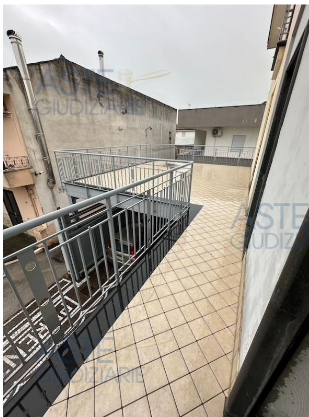
Foto n.10 – Particolare duplex sub 4
