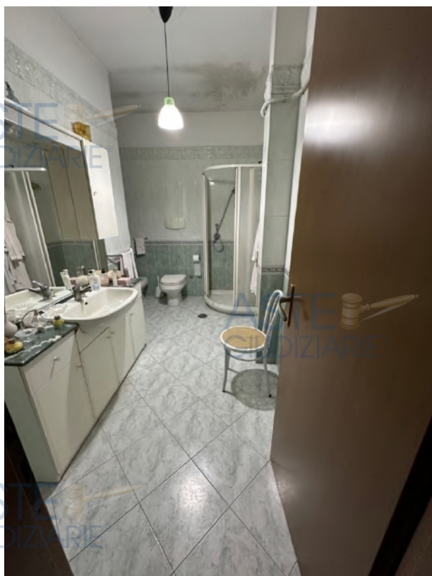
Foto n.5 – Particolare bagno sub 3
