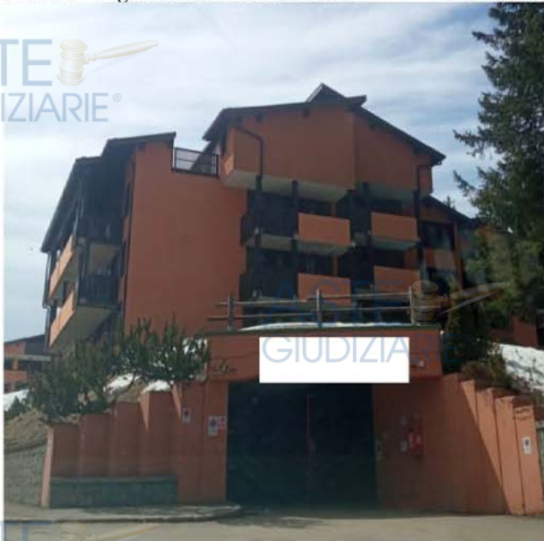
Foto n. 3 – Ingresso carrabile al Residence al civico 31
