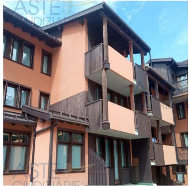
Foto n. 6 – Vista dei fabbricati in direzione nord est
