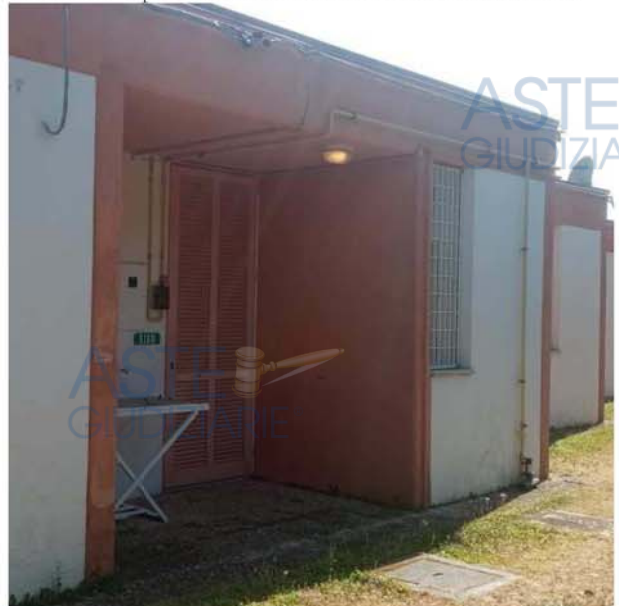
Foto n. 13 – Spazio esterno retrostante dell'unità immobiliare
