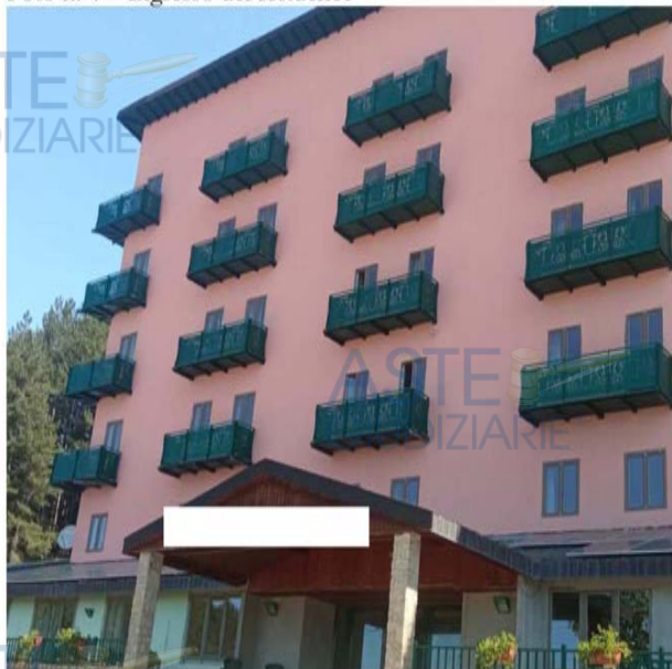
Foto n. 4 – Ingresso del residence
