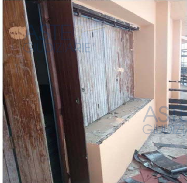
Foto n. 8 – Terrazzino di pertinenza
